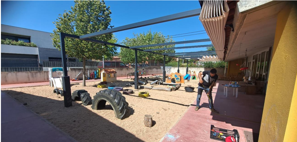
Vista del pati sud-oest amb la pèrgola provisional instal·lada
