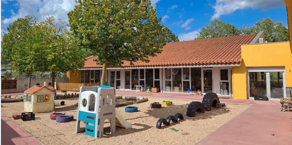
Vista del pati sud-oest
