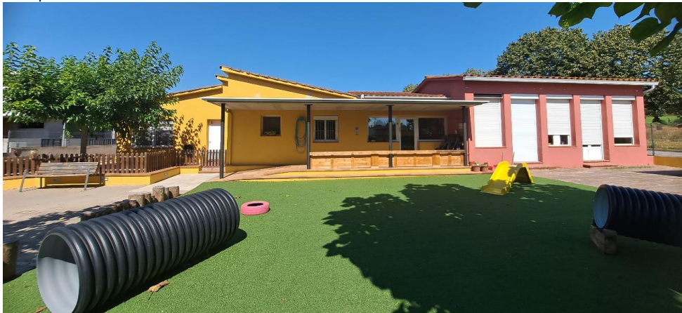
Vista de l'edificació des del pati est
