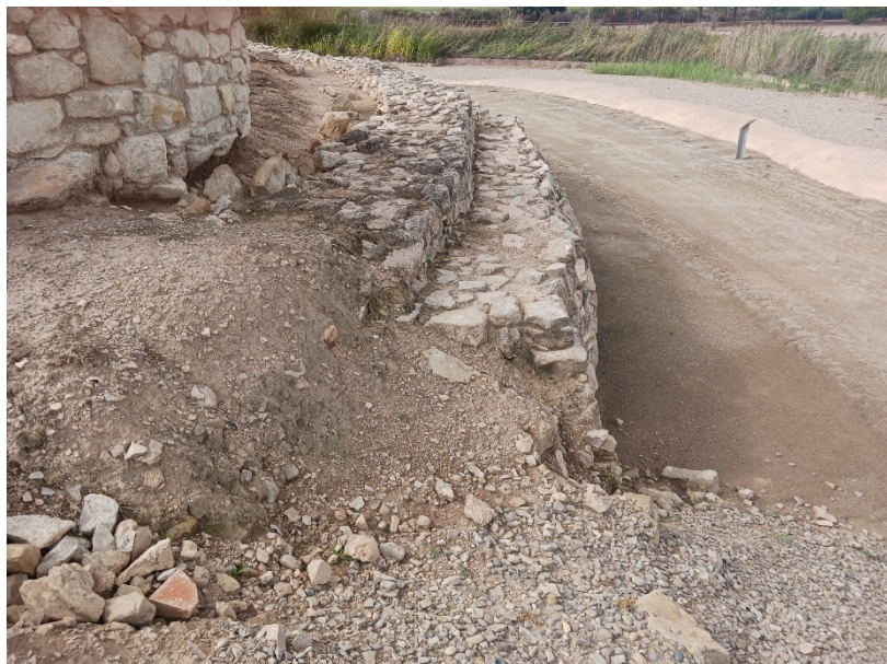
ESCARPA EXISTENT VISTA LATERAL COSTAT TORRE
