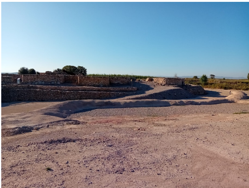
VISTA ACTUAL FAÇANA OEST, VISTA DES DEL CAMÍ D'ACCÈS
