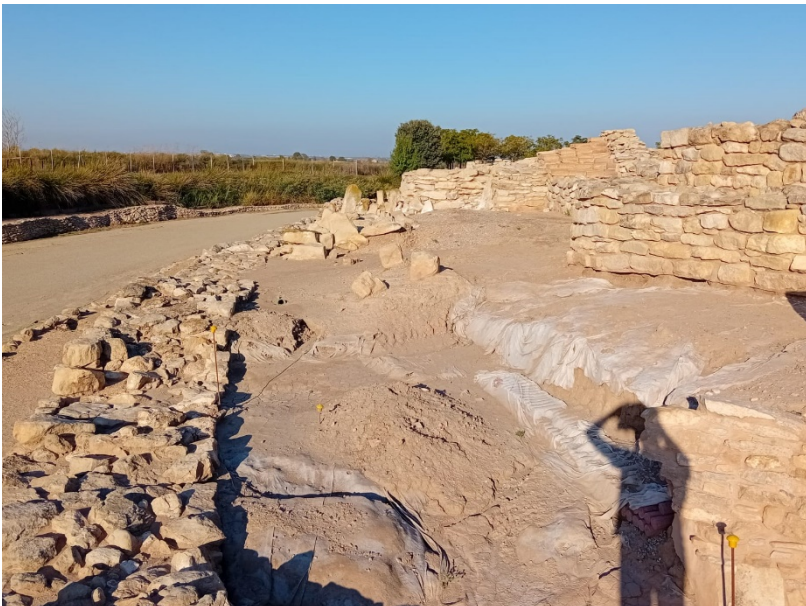
PLATAFORMA CAMP FRISIBASE DE LA TORRE I LLIURAMENT AMB LA BASSA
