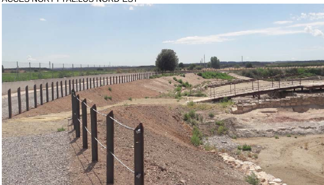
VISTA DELS ACCESSOS A LA FORTIFICACIÓ
