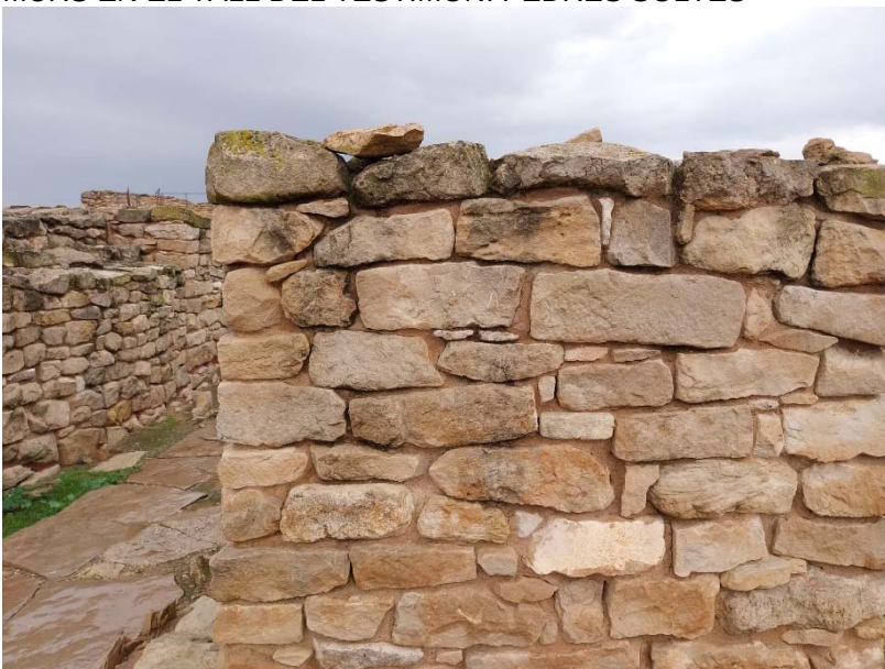
PORTA EST – REMAT DE MUR
