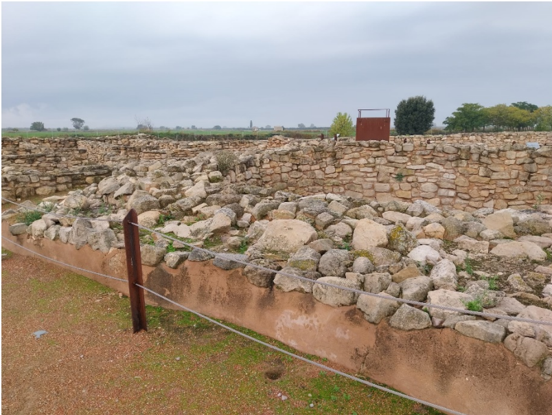
REMAT SUPERIOR CISTERNA ZONA PLAÇA
