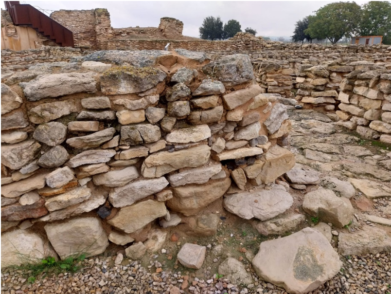
MURET ACCÉS PORTA NORD BASE DESCALÇADA
