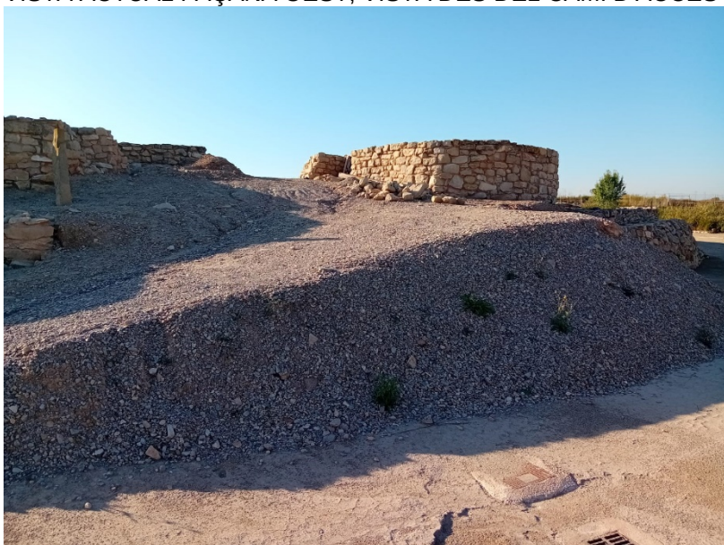
RAMPA D'OBRA (a eliminar) ACCES D'OBRA AL INTERIOR FORTIFICACIÓ
