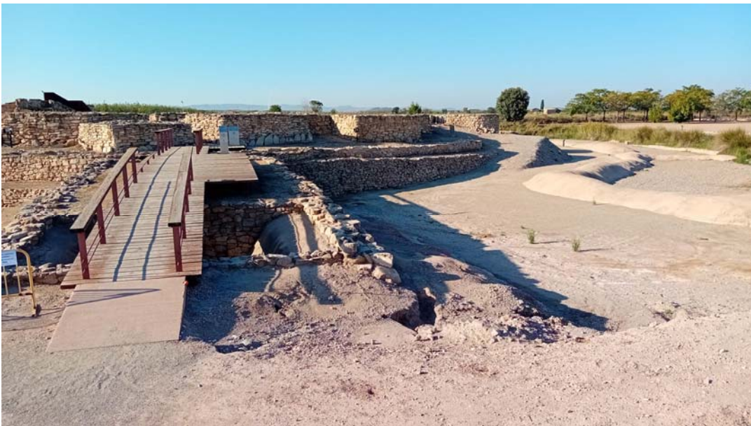
PLATAFORMA ACCÈS NORD MURALLA I ESCARPA NORD-OEST FOSSATI BASSES
