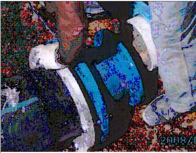
CONNEIXIÓ DE POLIETILÉ A FIBROCIMENT
