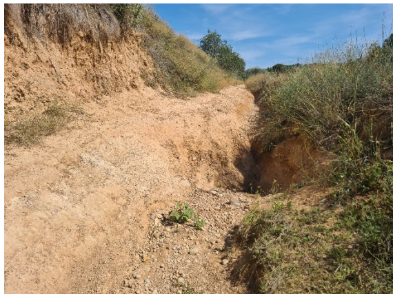
Pista que funciona com a drenatge al tram comprès entre el pont del Torrent de Torres de la Mata i la urbanització de Can Claramunt (punt JM16).
