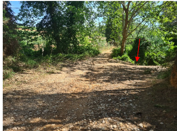
Pista que creua el Torrent Can Torres de la Mata (punt JM14) per mitjà d'un pont. La fletxa vermella indica la zona de degradació.
