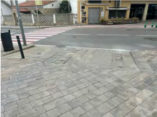
SUBSTITUCIÓ DE PECES DE FORMIGÓ
