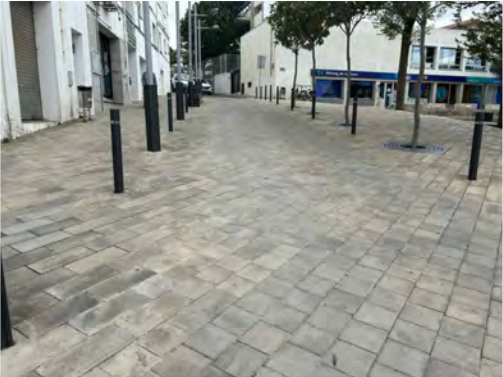
REPARACIÓ DE PAVIMENT
