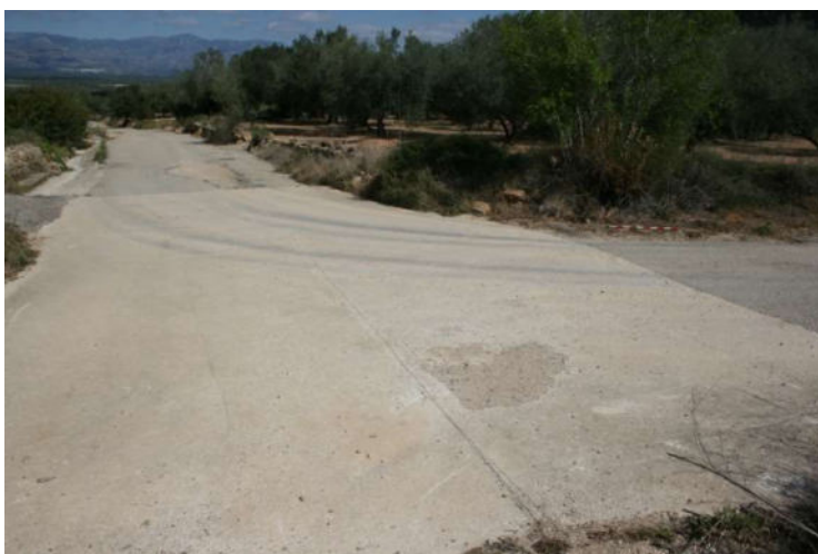
5.1 Zona alta del lligallo. Encreuament de camins. Es necessari fer un cavalló per canalitzar les aigües en direcció a la cuneta.
