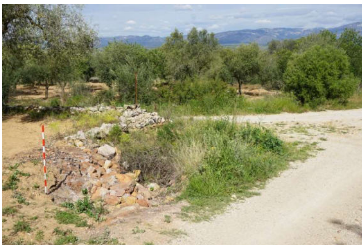
4.7 Cuneta plena de pedres que barren el pas a les aigües.
