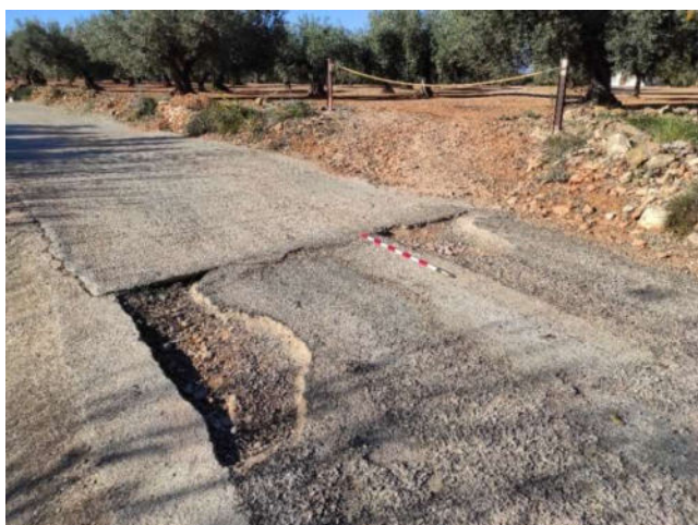
1.1 Camí malmès per l'erosió de les aigües que baixen del bancal d'oliveres.
