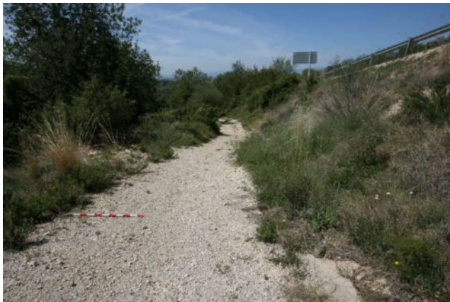
3.1 Cuneta plena de terres i herbes. L'aigua salta al camí i l'erosiona.
