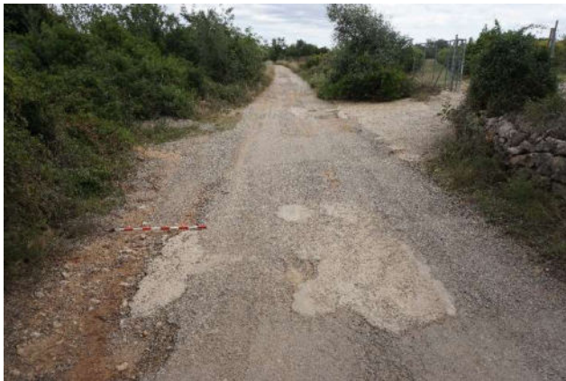
1.8 El camí reb les aigües del camp superior. S'ha de formigonar una llosa de 3,5x10 m.
