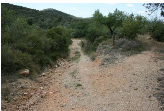
3.5 L'erosió ha buidat les terres del camí fins l'estrat rocós.
