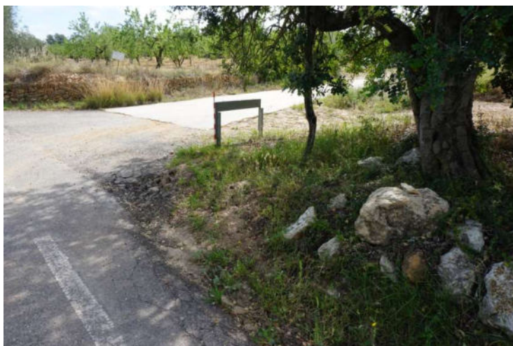
4.8 Sortida del camí a la carretera Godall-Ulldecona. S'ha de buidar la cuneta de terres.
