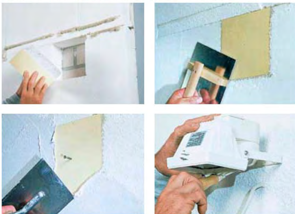
Figura 45. Instalación de un elemento de fijación para una carga pesada
