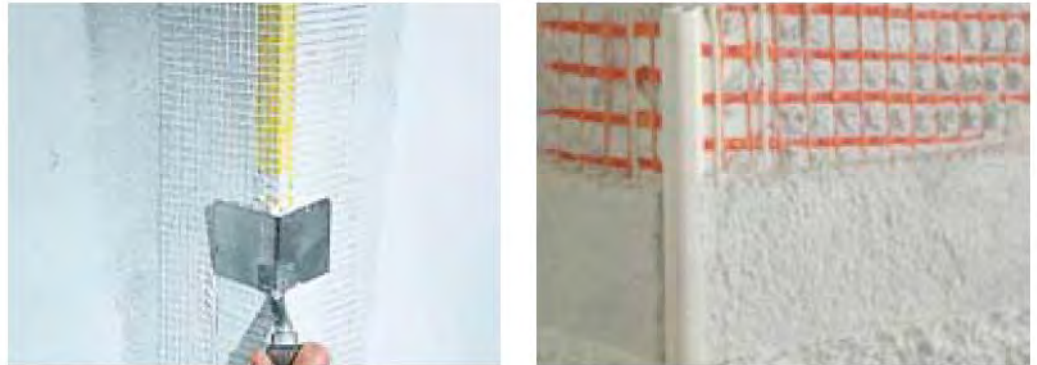
Figura 46. Detalle de aplicación de un perfil de esquina
