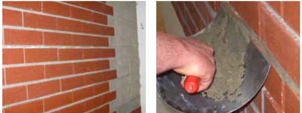
Figura 37. Detalle de la instalación de un acabado de aplacado imitando ladrillo cara vista
