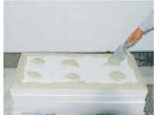
Figura 4. Detalles del pegado borde-punto de las planchas de aislamiento
