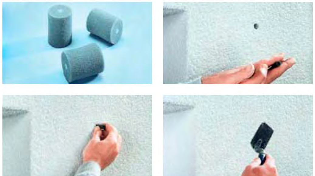
Figura 47. Detalle de una tapa de anclaje de andamio y su correcta instalación
