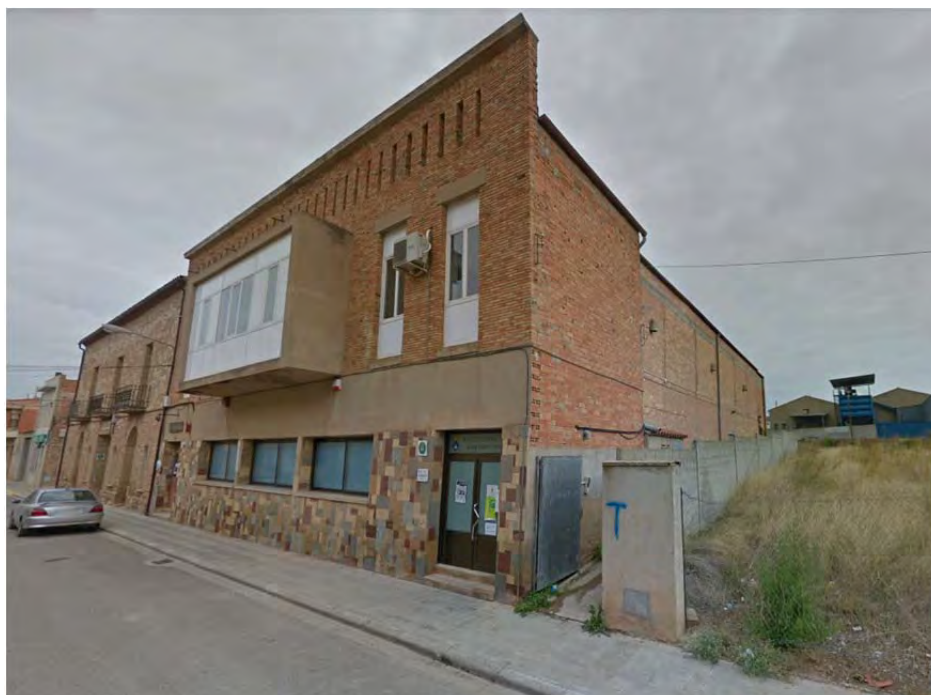
Façana principal (sud-oest) edifici de la Llar del Productor.
