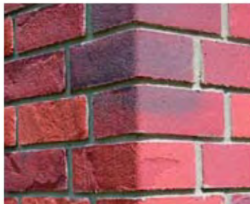
Figura 39. Detalle de esquina de la instalación de un acabado de ladrillo sobre un sistema SATE
