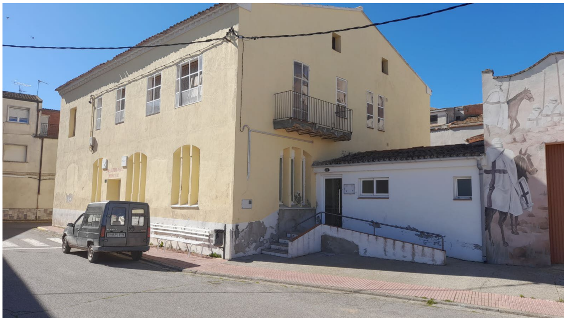
Imatge en la que es visualitza l'edifici principal i l'annex d'accés al local
