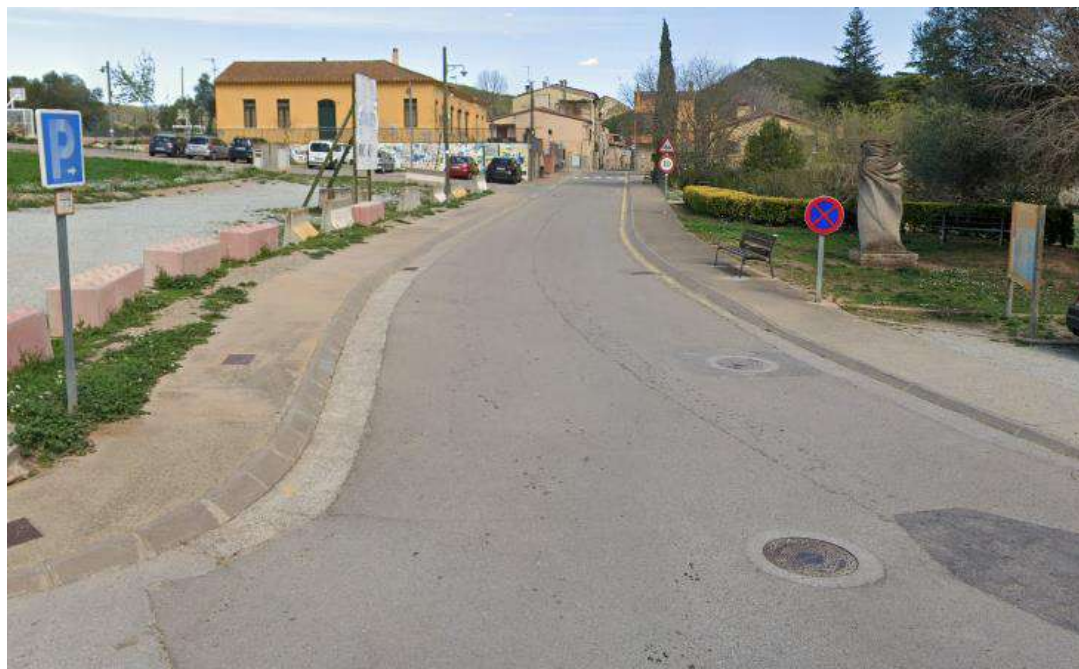
Figura 13. Estat actual vialitat (Carrer Nou)
