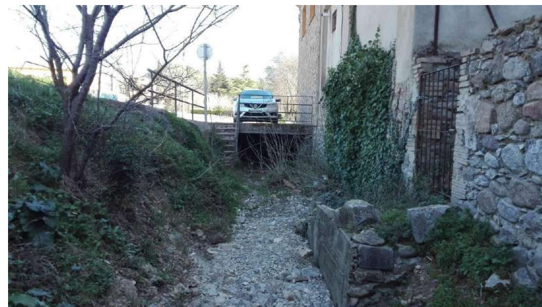
Figura 7. Estat actual obra entrada hidràulica dels carrers Nou i Sant Gaietà (Torrent La Coromina)
