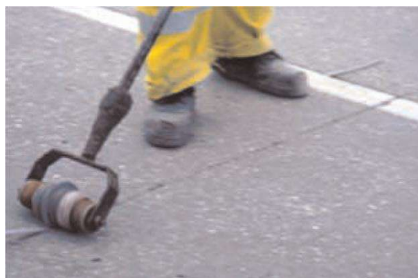
Figura 77. Imatge instal·lació d'obturgador en el fons del tall.
