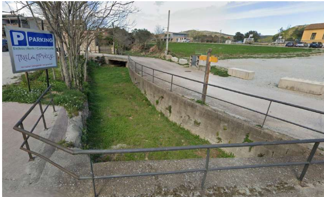
Figura 8. Estat actual entrada obra hidràulica dels carrers Nou i Sant Gaietà (Torrent Serra de Cal Fuster)
