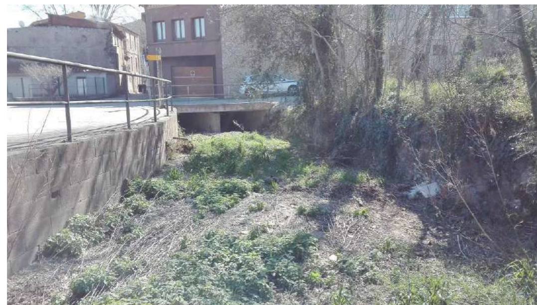
Figura 6. Estat actual entrada obra hidràulica dels carrers Nou i Sant Gaietà (Torrent Serra de Cal Fuster)
