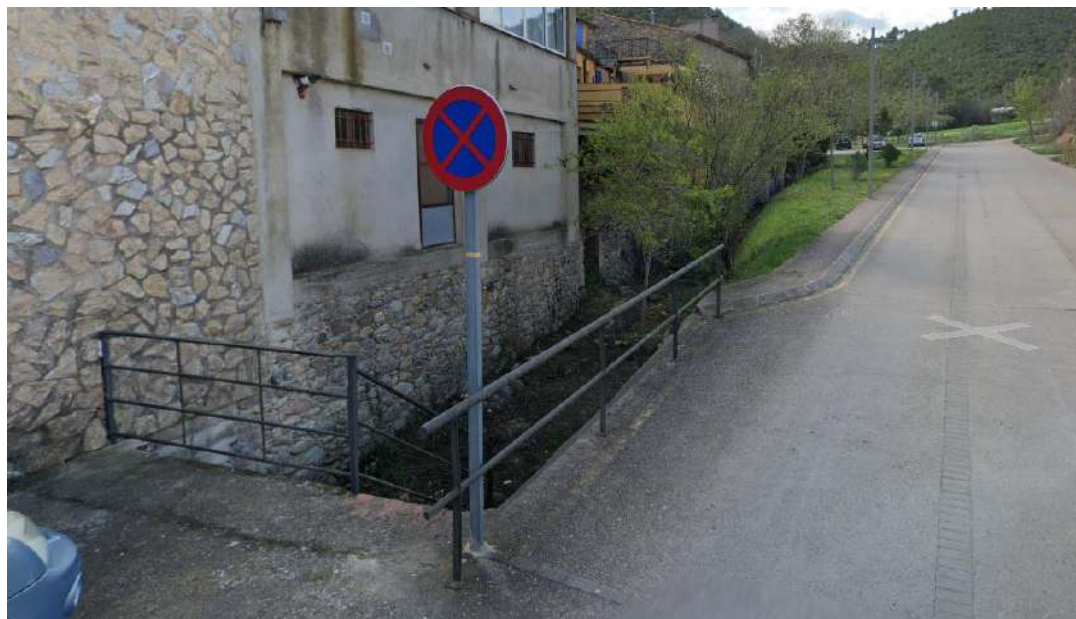
Figura 9. Estat actual entrada obra hidràulica dels carrers Nou i Sant Gaietà (Torrent La Coromina)
