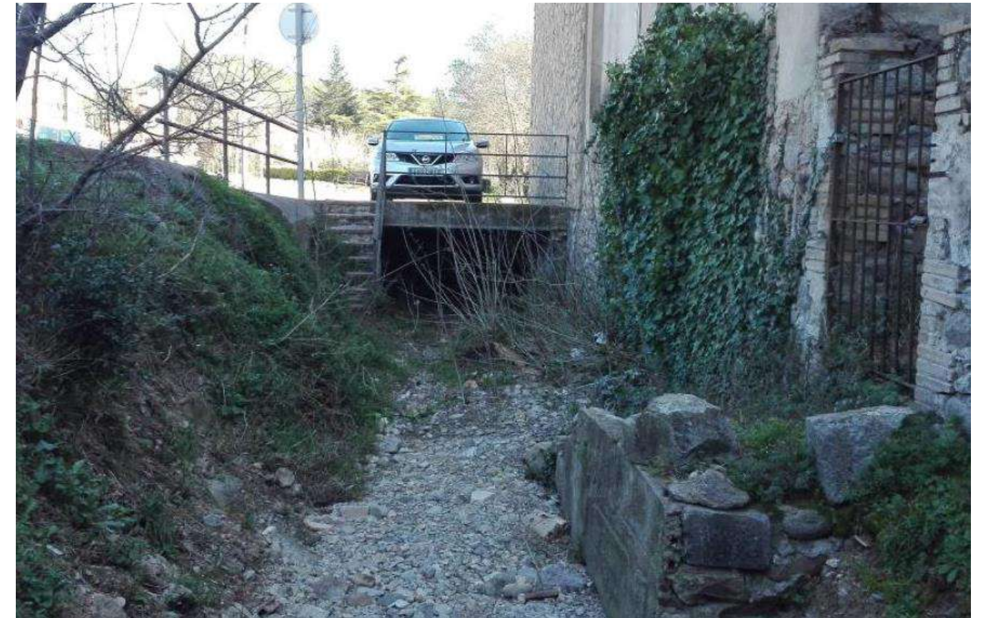
Figura 24. Imatge estat actual escala existent a retirar.
