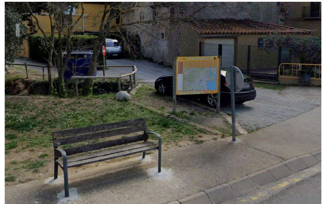
Figura 15. Estat actual sortida obra hidràulica
