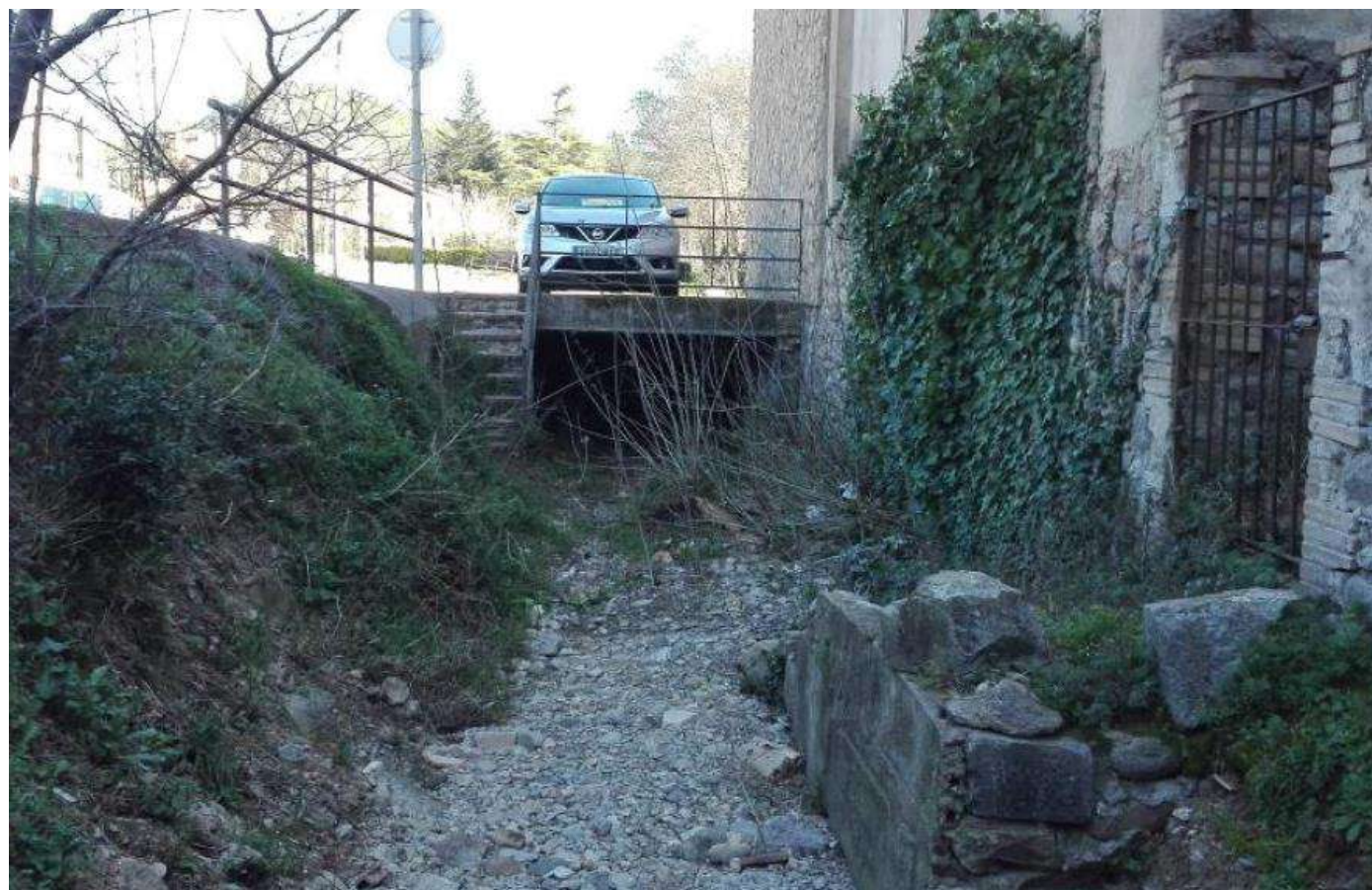
Figura 52. Imatge estat actual escala existent a retirar.
