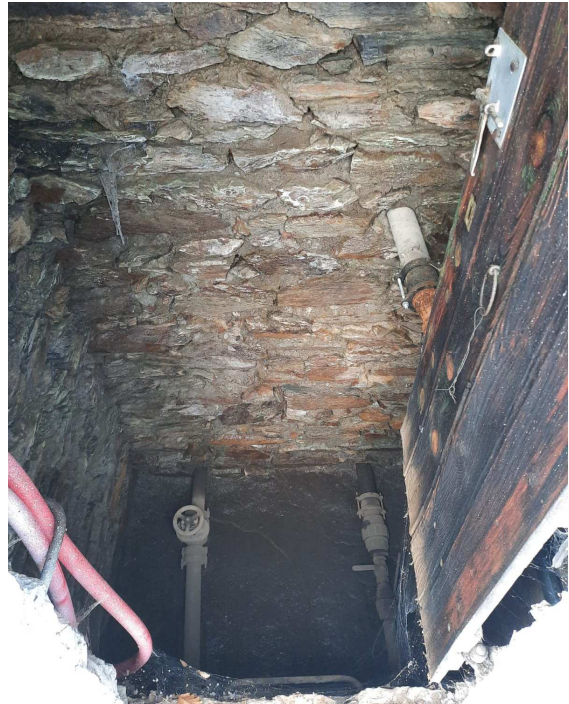
FOTO 15 – Vista de l'interior de la caseta.
