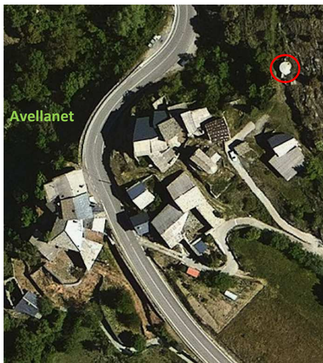
FOTO 19 – Vista del dipòsit d'Avellanet Coordenades ubicació: 42.351247, 1.329317
