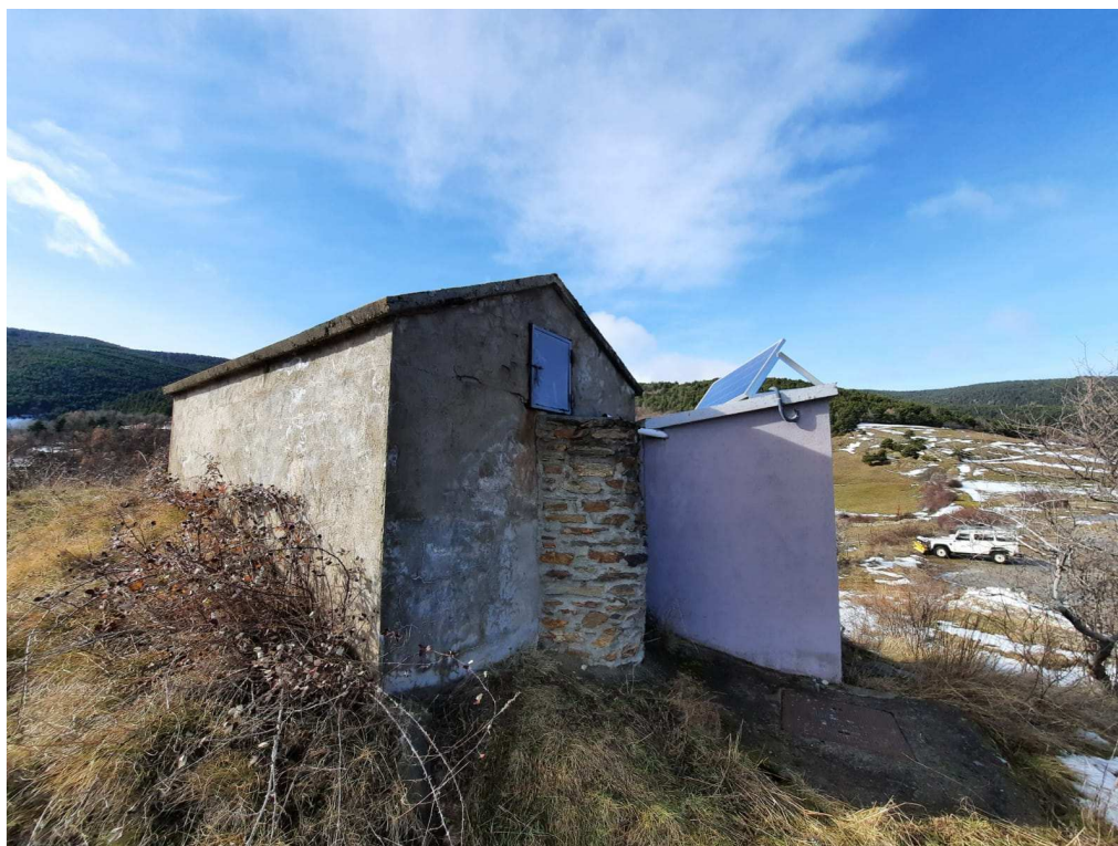
FOTO 11 – Vista del dipòsit de Sant Andreu de Castellbò.
