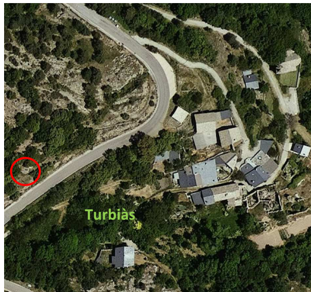
FOTO 7 – Vista del dipòsit de Turbiàs Coordenades ubicació: 42.380895, 1.320895
