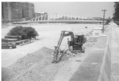
DEMOLICIÓN MECÁNICA A CIELO ABIERTO
