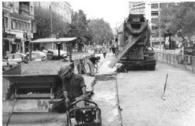
VERTIDO DE HORMIGÓN DE FIRME
