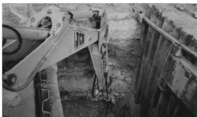
DEMOLICIÓN MECÁNICA EN ZANJA
