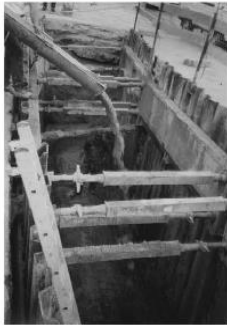
VERTIDO DE HORMIGÓN DE RECUBRIMIENTO
