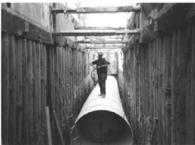
COLOCACIÓN TUBERÍA DE PVC. (RIB-LOC)
