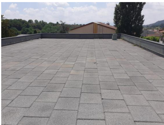
Imatge general de la coberta objecte de l'actuació
