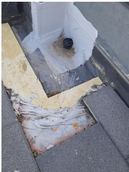
Detall zona exterior
