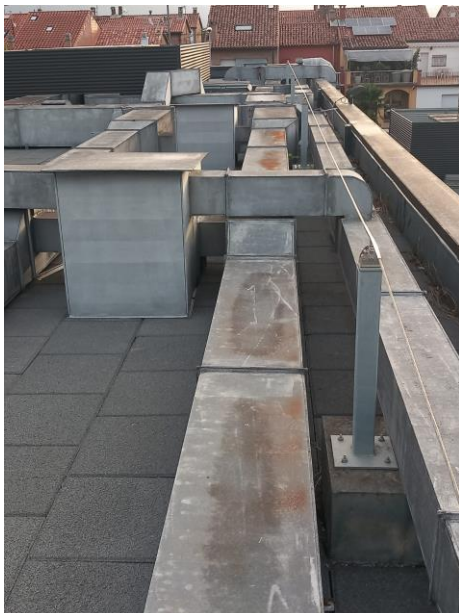
Imatge general de la coberta
