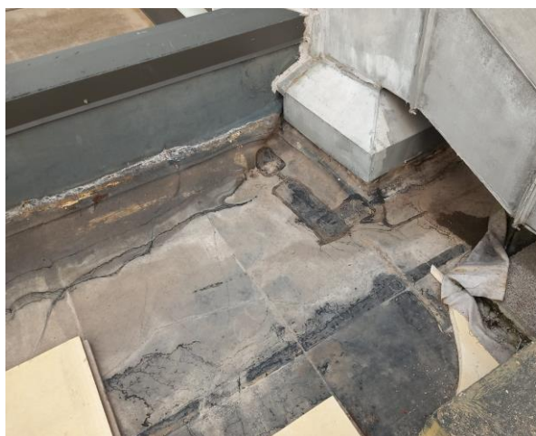
Detall zona exterior
