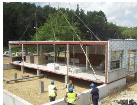
Muntatge mòdul prefabricat en fase d'execució.
