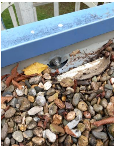
Trencament de la làmina per tensions o elements perforants.
