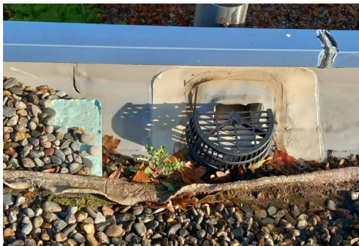
Trencament de la làmina per tensions o elements perforants.
