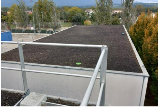
Imatge general de la coberta del gimnàs
