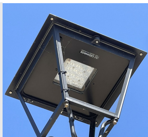
L·luminàries adaptades a zona E1 (model col·locat en diversos punts del municipi)
