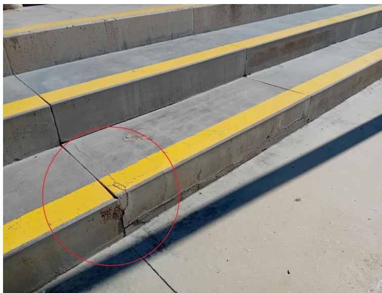
Esquerdas de les Grades de la pista poliesportiva.
