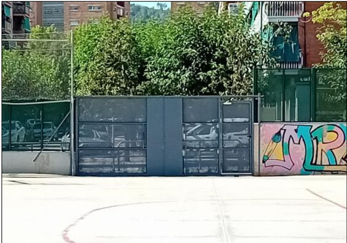
Porta corredissa d'accés a la pista des del carrer.
