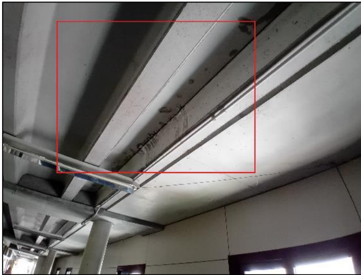
Danys interiors a la planta primera de l'edifici principal degut a les goteres (principalment passadissos)
