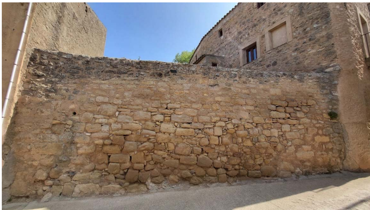
Foto 1. Vista general de mur de contenció de terres del pati intermig de l'Abadia des del C/Major
