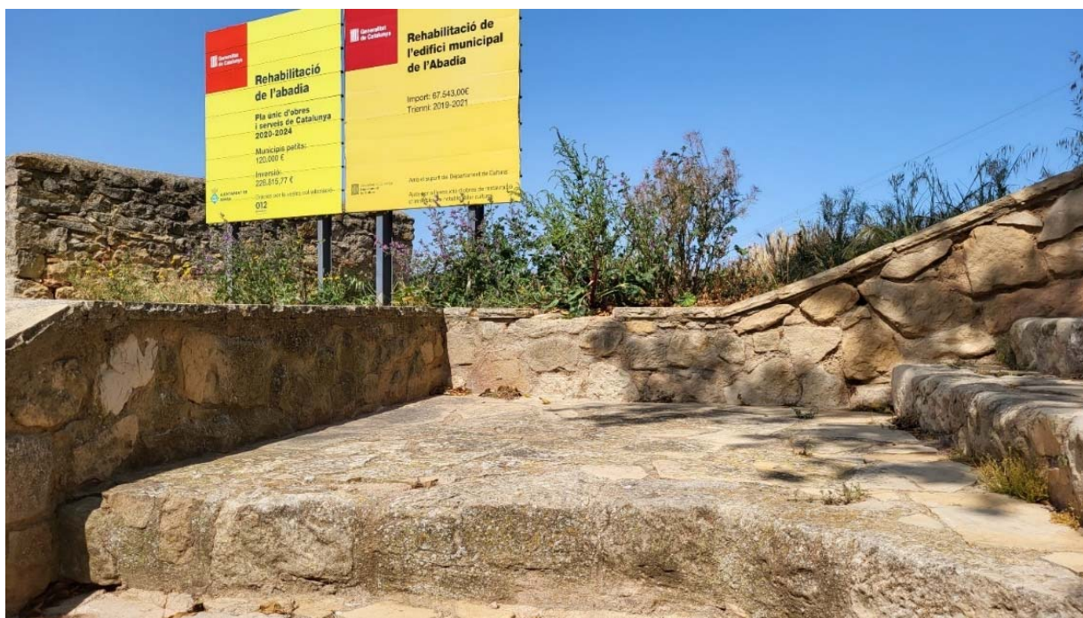
Foto 6. Repla de la part superior, al nord de l'Abadia, on es farà l'accés a la nova plaça.
