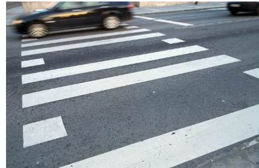
Figura 83. Pas de peatons amb reducció de pintura.
