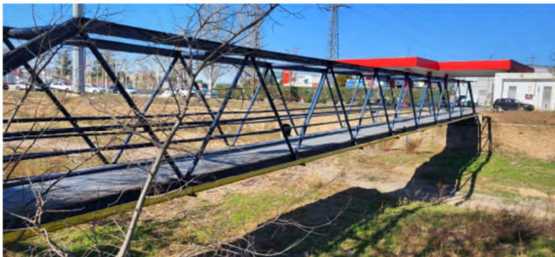
Figura 2: Estructura passera actual (Biga Warren)
