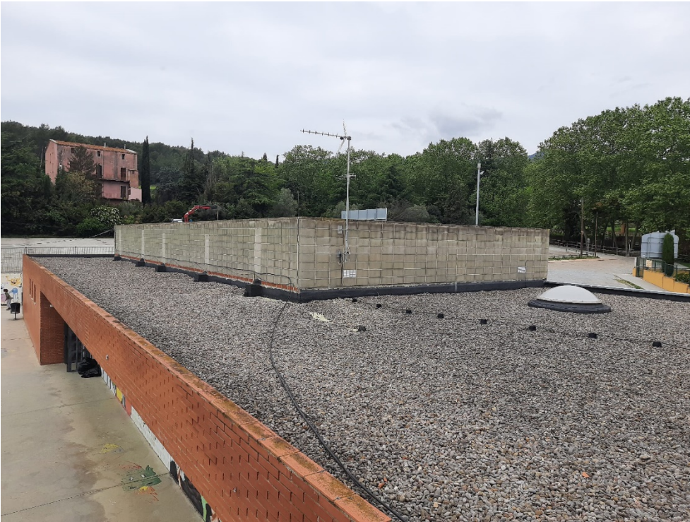
Il·lustració 3: Superfície solar nord-oest del CEIP L'estelada.
