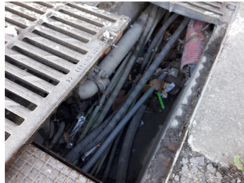
Figura 16.- Canaleta de creuament de serveis
