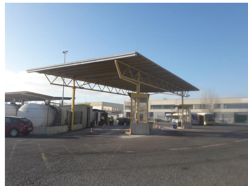
Figura 12.- Dipòsits i marquesina a desmantellar
