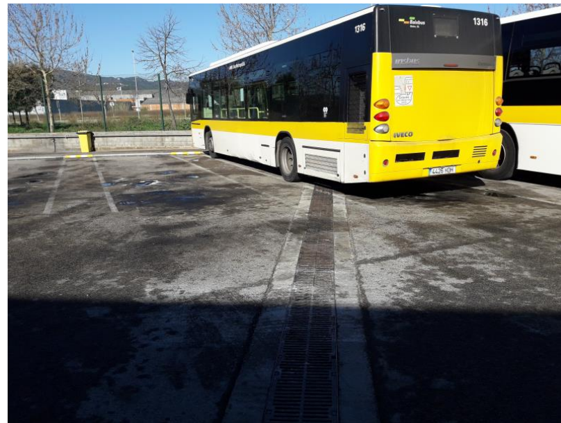
Figura 17.- Canaleta de creuament de serveis
