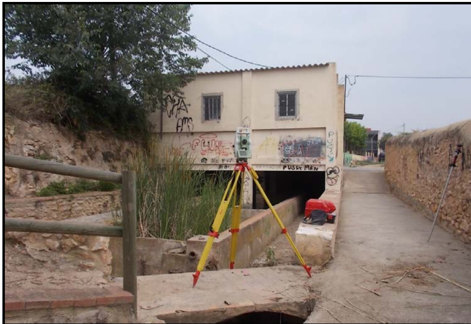
Estat actual del recinte vist des de la part posterior on es veu l'antic rentador sota l'edificació, semi soterrat.
