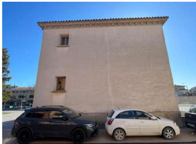
Figura 6. Imagen del estado actual de la fachada OESTE.
