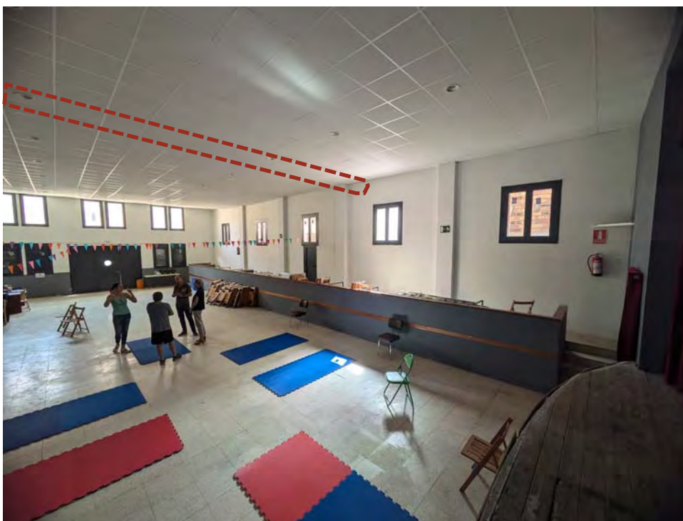
Sala polivalent indicant la posició del conducte de climatització/ventilació
