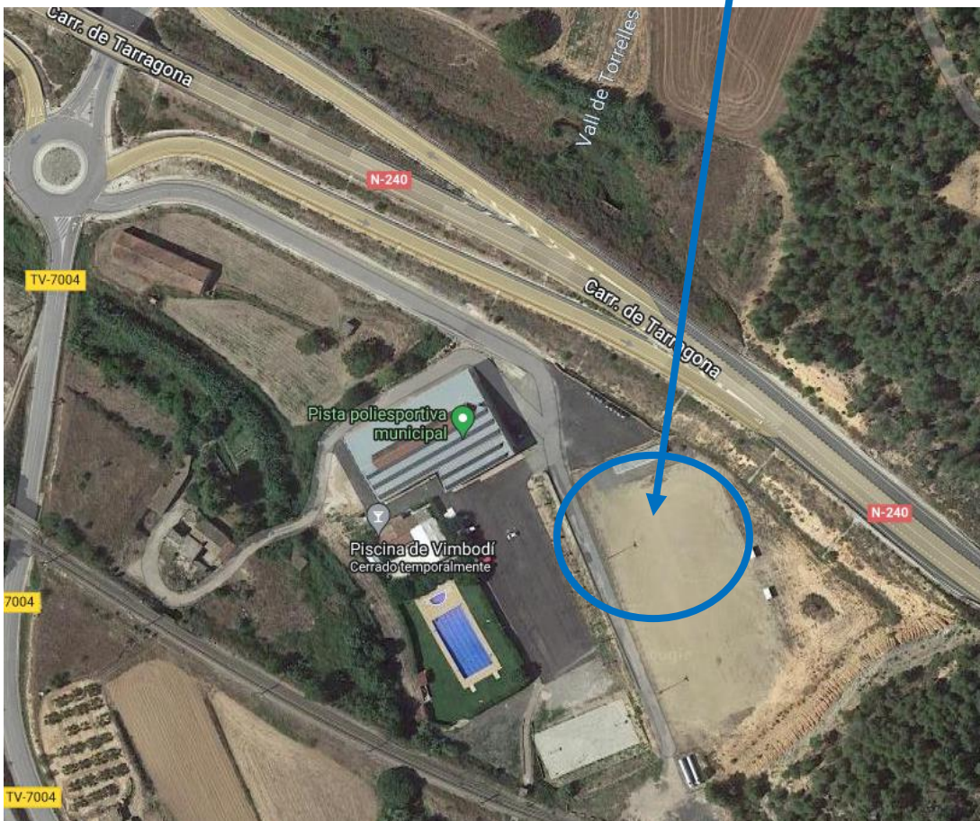
Figura núm. 1. Vista general de la zona d'actuació.
