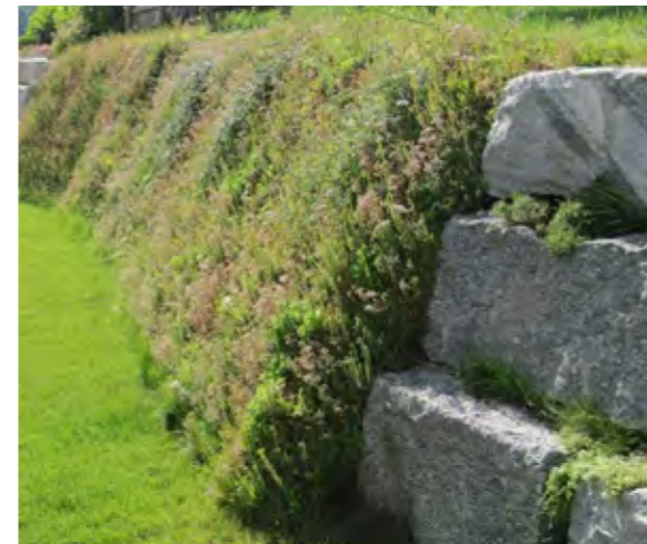
mur verd amb retenció de geo cel·les
