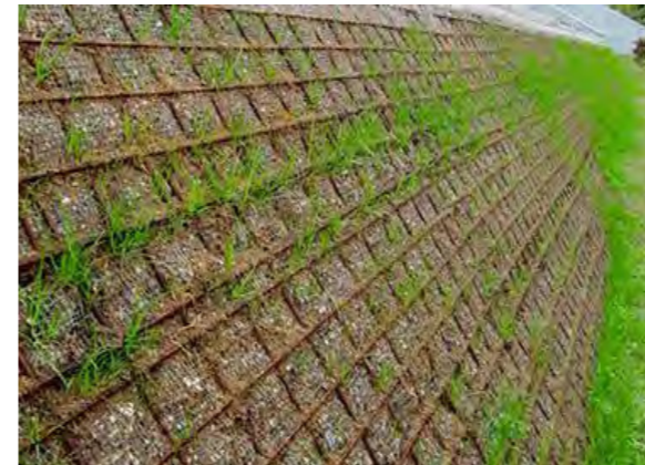
mur verd amb contenció d'emmallat d'acer
