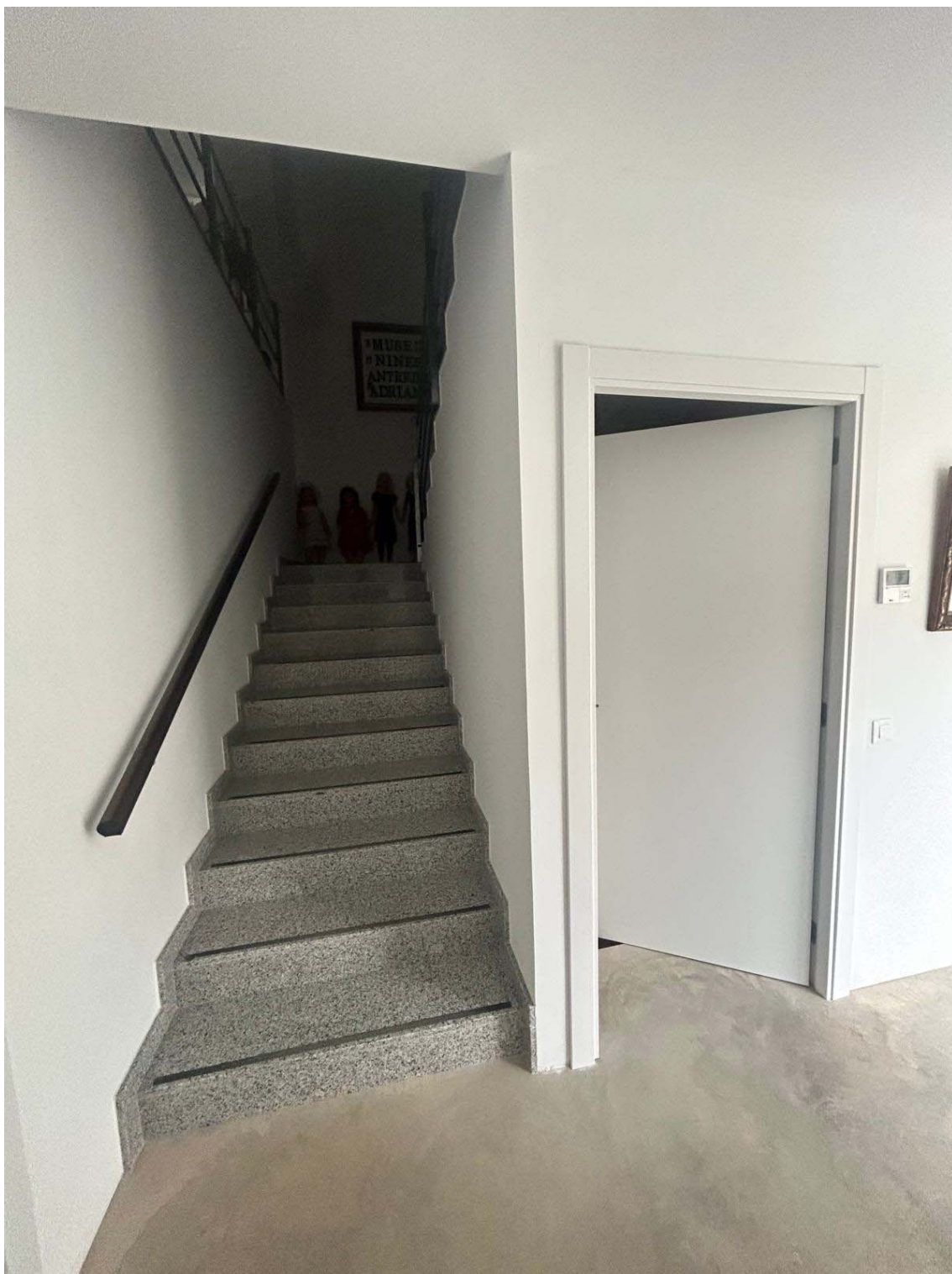
Estat actual escala per on pujarà l'elevador
