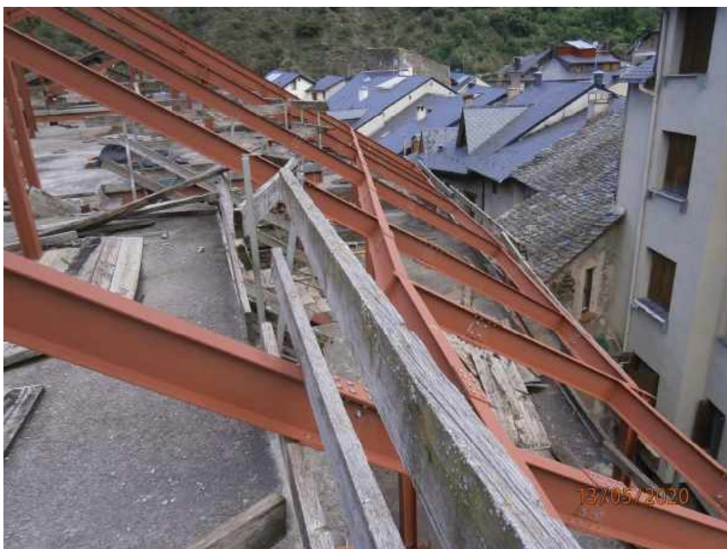
Estructura de coberta – detall de les unions
