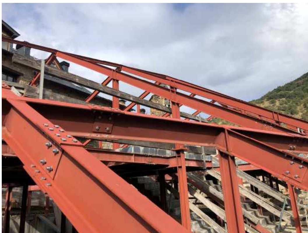
Estructura de coberta – detall de les unions
