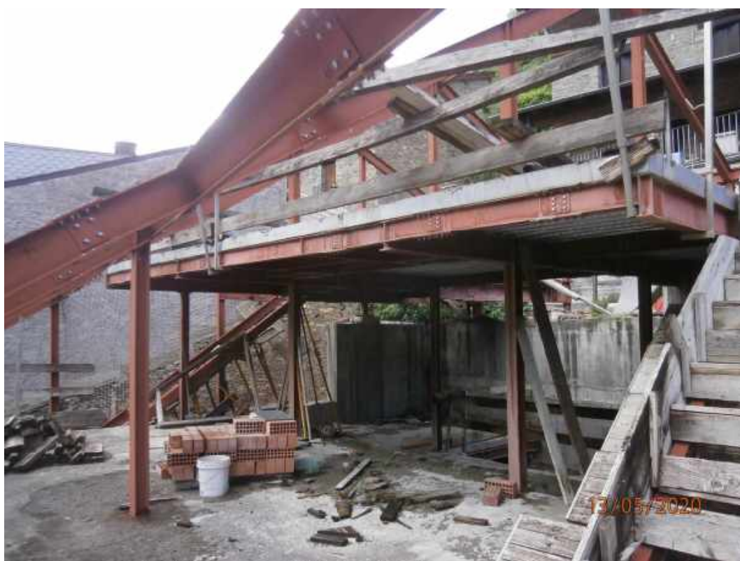
Vistes de la 3a planta de l'edifici ( les dues escales encofrades pendents de formigonar)
