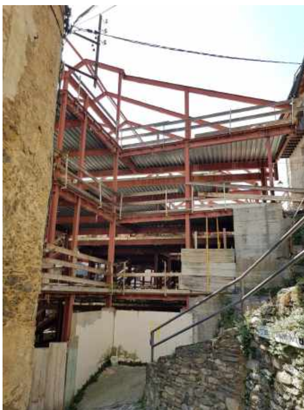
Vista de l'edifici des del carrer Exceomo
