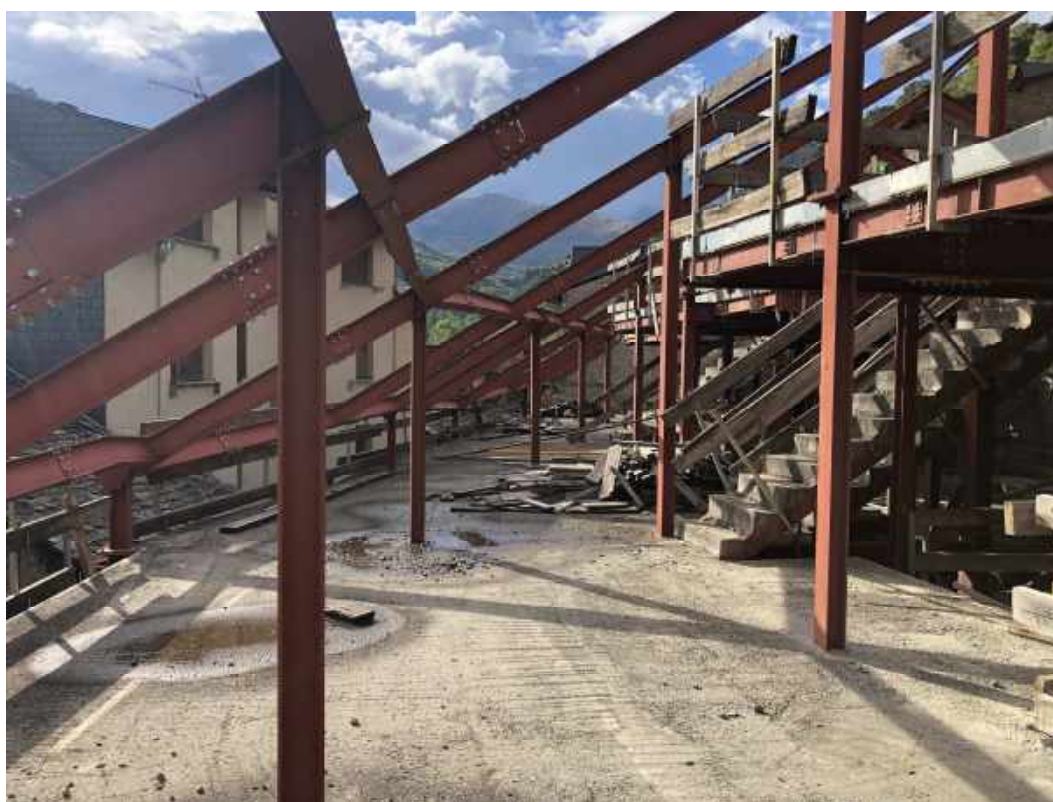
Vista de la 3a planta de l'edifici (escala formigonada)
