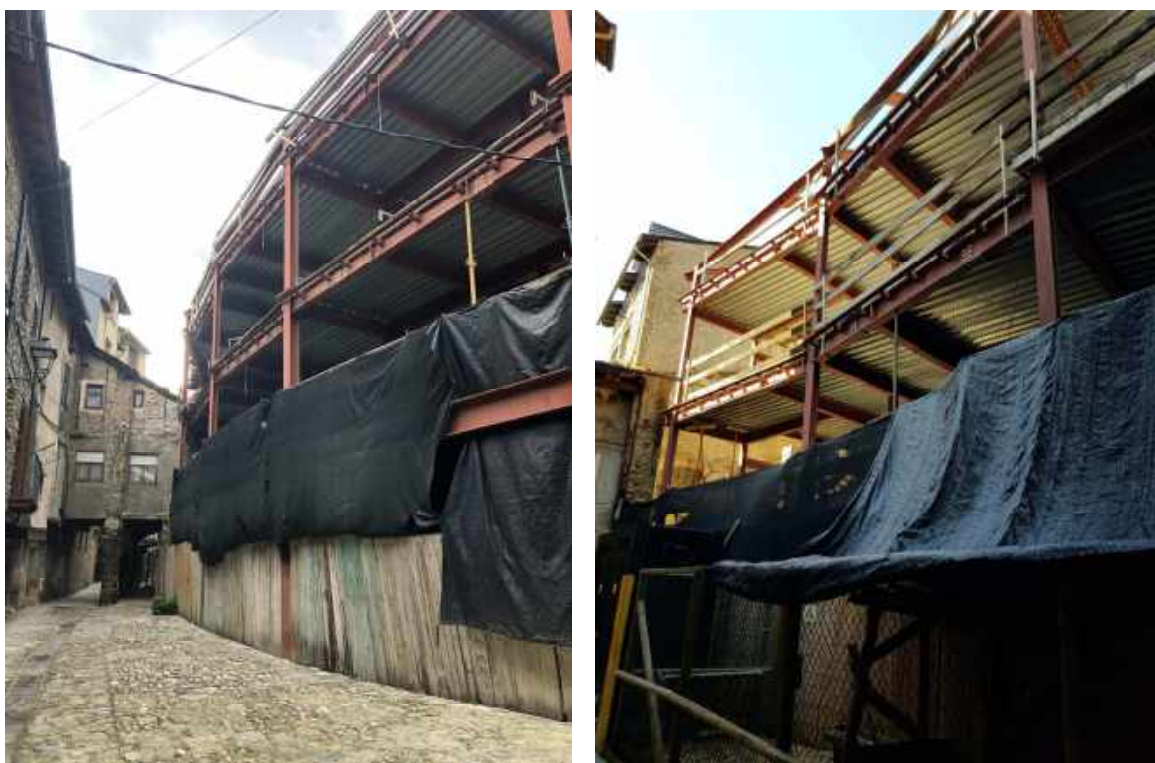
Vistes de l'edifici des del carrer del Mig
