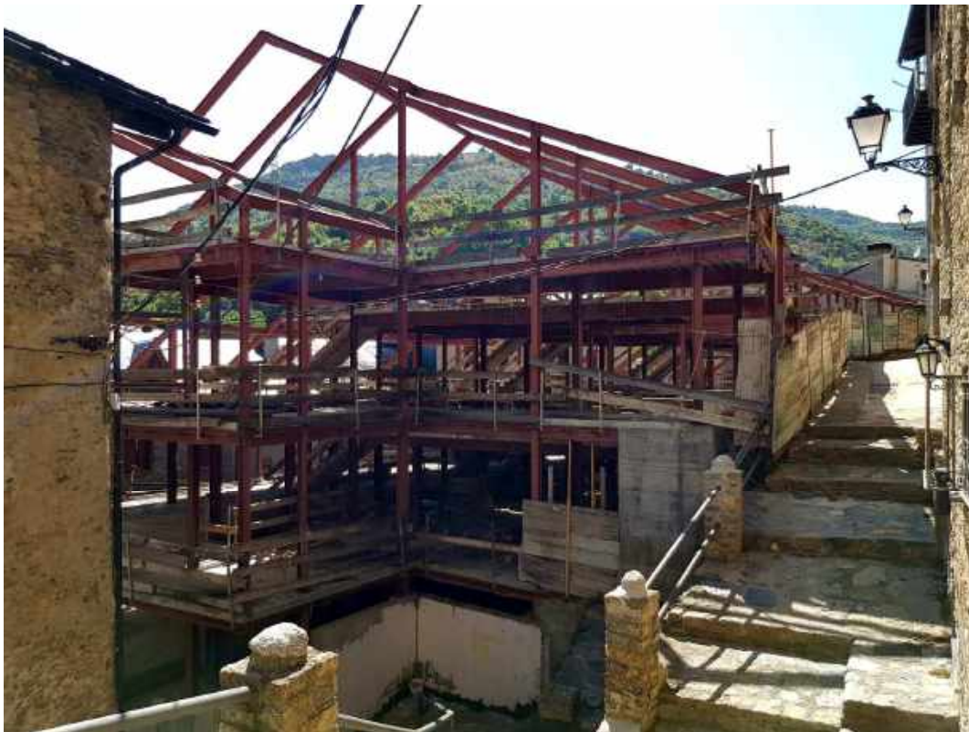
Vista general de l'edifici des del carrer de la Costa
