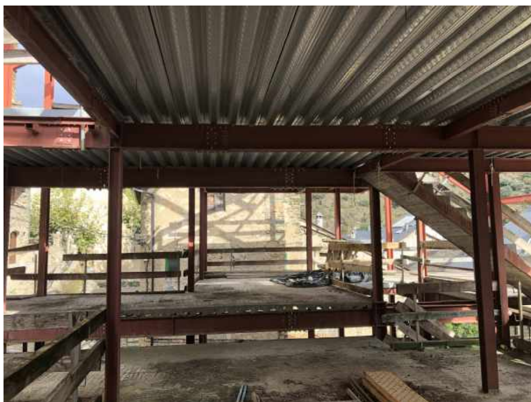
Vistes de la 3a planta de l'edifici ( les dues escales encofrades pendents de formigonar)
