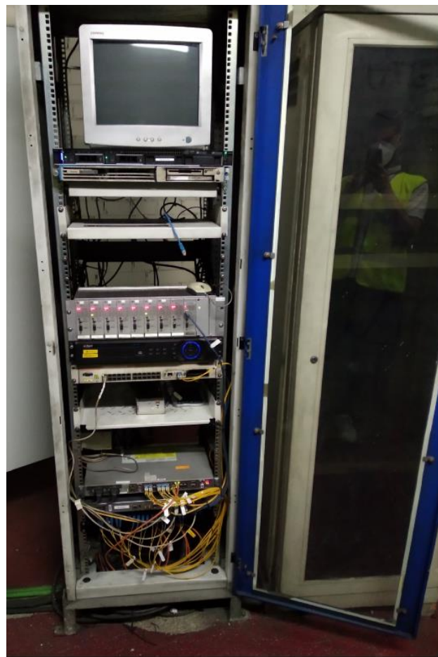
Armaris de connexió de fibra òptica i de comunicacions de l'IMI
