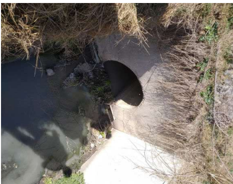
Figura 3. Punt d'abocament del sobreexidor
