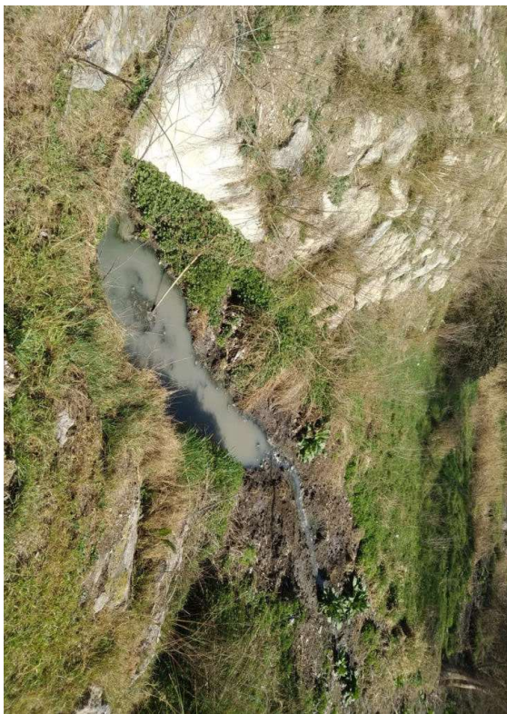
Figura 8. Punt d'abocament del sobreexidor
