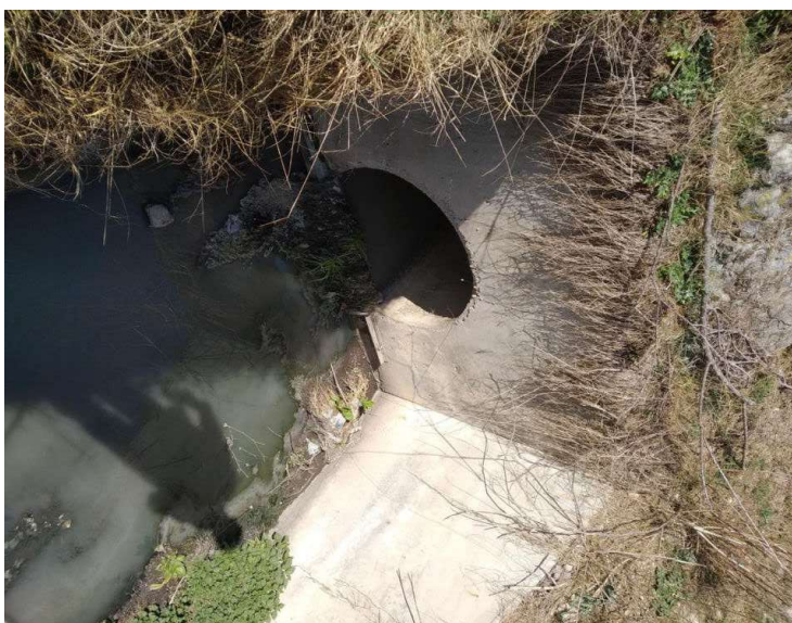
Figura 7. Punt d'abocament del sobreeixidor
