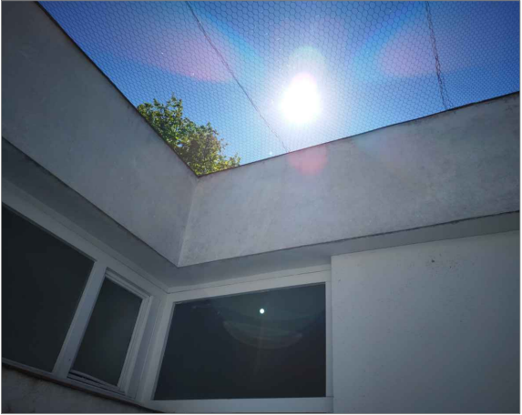
Foto 2. Pas canonades a coberta
