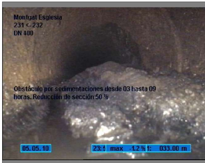
Foto: 3_2A 33m, Obstáculo por sedimentaciones desde 03 hasta 09 horas. Reducción de sección 50 %
