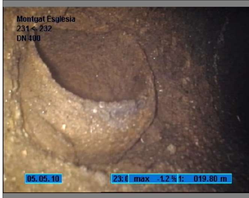
Foto: 3_2A 19,8m, Acometida desde 07 hasta 11 horas
