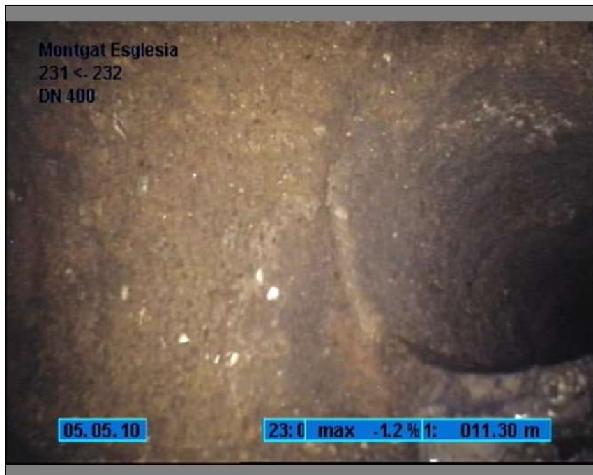
Foto: 3_2A 11,3m, Acometida desde 01 hasta 04 horas
