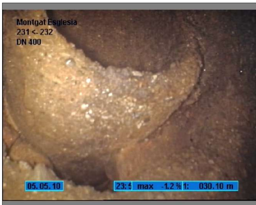
Foto: 3_2B 30,1m, Acometida desde 07 hasta 10 horas
