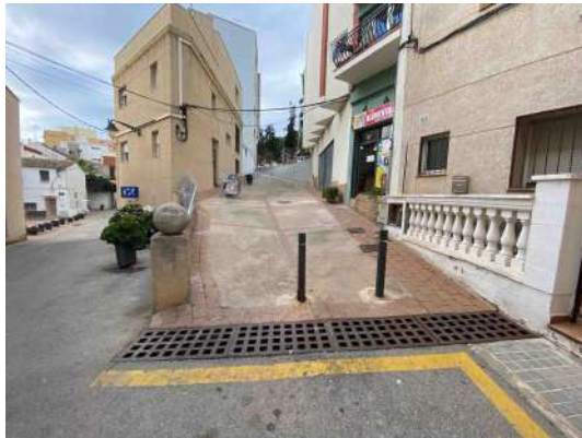
Reixa de recollida d'aigües pluvials
