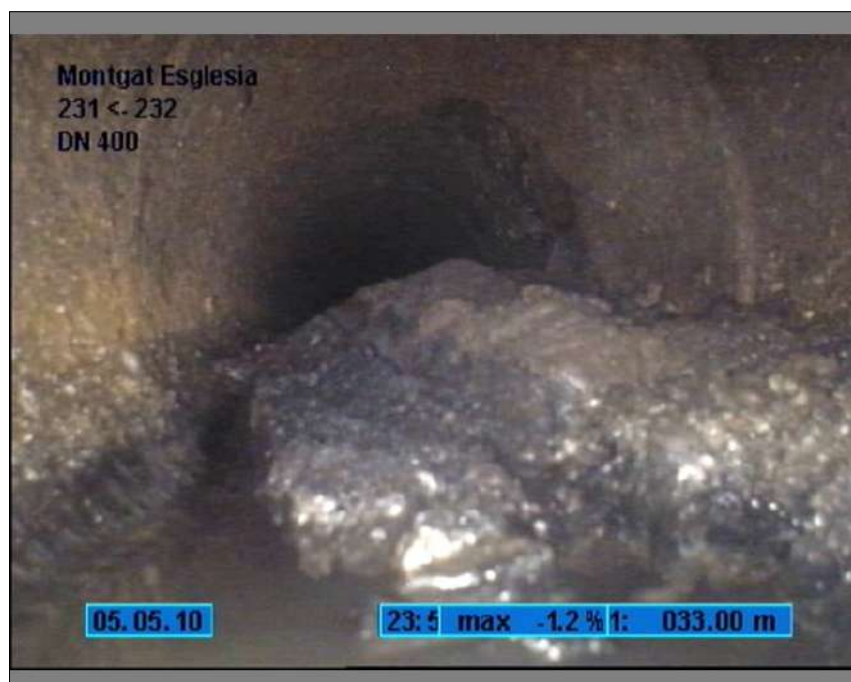
Foto: 3_2B 33m, Obstáculo por sedimentaciones desde 03 hasta 09 horas. Reducción de sección 50 %
