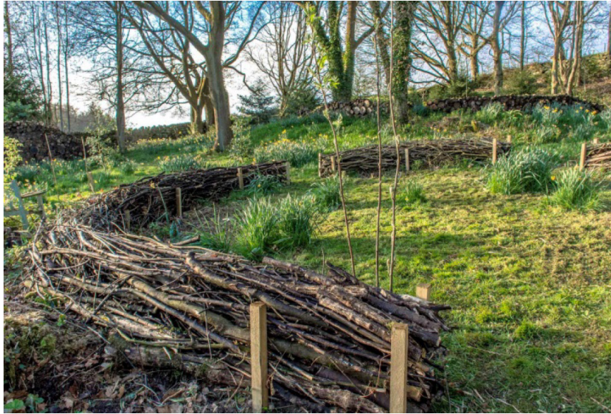
Imatge de referència de feixines amb estaques com a suport de l'estructura
