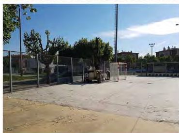
Il·lustració 14. Màquina Rolatec realitzant el Sondeig S-2 a la pista poliesportiva.
