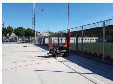
Il·lustració 15. Màquina Tecóines realitzant el DFGH P-2 a la pista poliesportiva. S'aprecia el bon estat del paviment actual.
