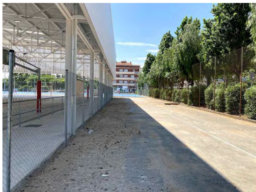
Imatge 07 - Espai lliure per la futura edificació. Tanca perimetral sobre murete de obra i la coberta per la pista poliesportiva
