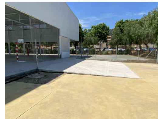
Imatge 09 - Rampa d'evacuació, de formigó. Solera de formigó pintat i antiga pista de tennis amb tanca perimetral
