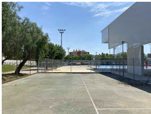
Imatge 08 - Antiga pista de tennis i tanca perimetral sobre murete d'obra
