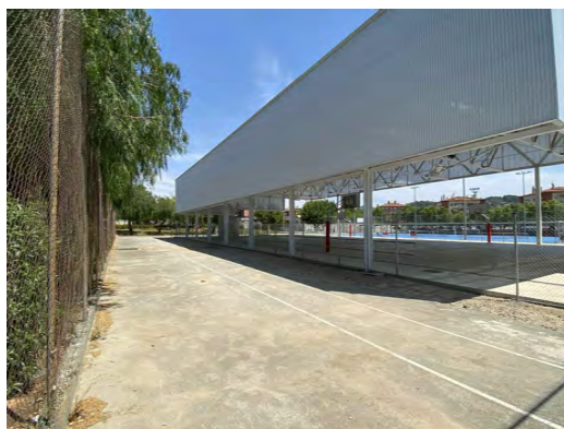
Imatge 05 - Espai lliure per la futura edificació. Tanca perimetral sobre mureta de obra i la coberta per la pista polideportiva
