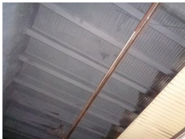
Estat actual encofrat perdut sobre zona de via 1 i via 2
