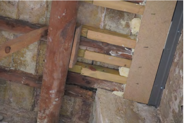
Imatge 4. Intervenció d'urgència caps llatres (d-01 - d-12)
