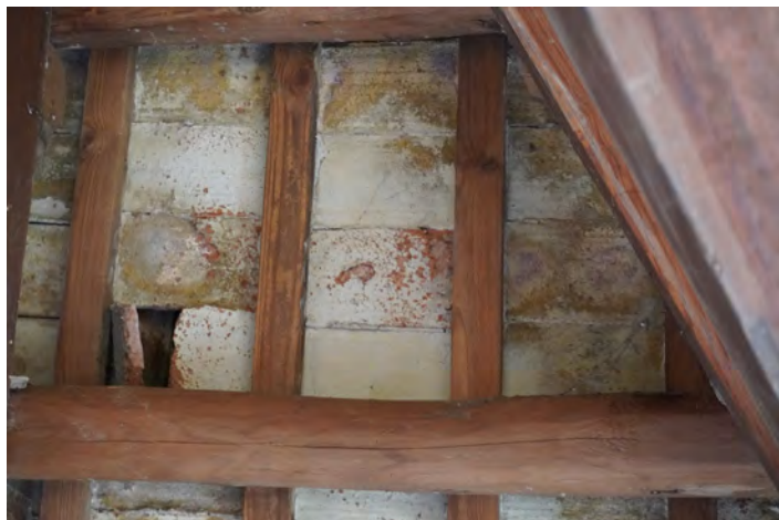
Imatge 028 - Tauler ceràmic, amb rajols puntuals trencats i/o meteoritzats
