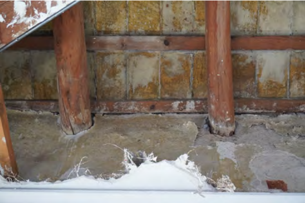
Imatge: F1. Degradació parament. Filtracions i humitat.
