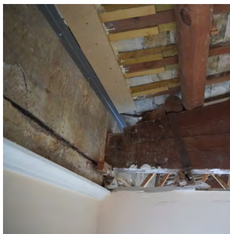
Imatge 029 - Ala superior del perfil encastat al mur de façana.
