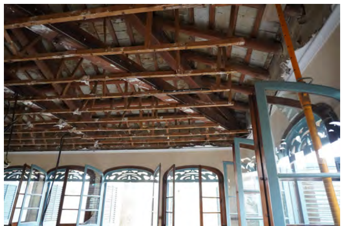
Imatge 013 - Estructura de la teulada: encavallades i corretges de fusta, llates de fusta i solera ceràmica de maó massís; i entramat de fusta de suport del cel·las
