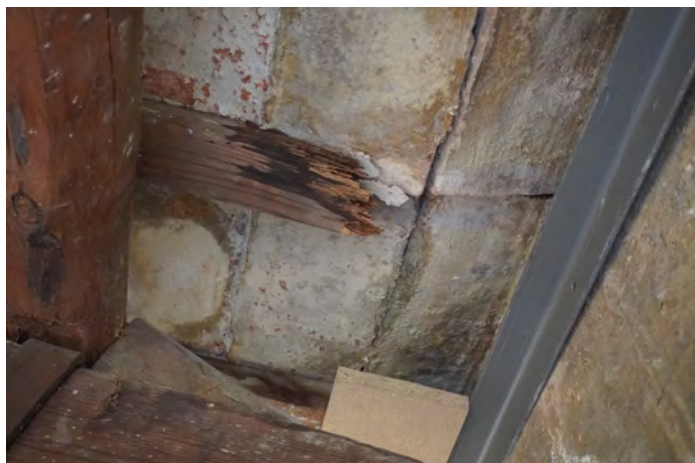
Imatge 022 - Degradació llates de les llates i descens dels rajols de la solera
