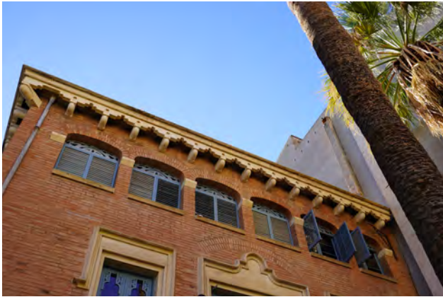
Imatge 8. Obertures façana nord (P2 - àmbit projecte)
