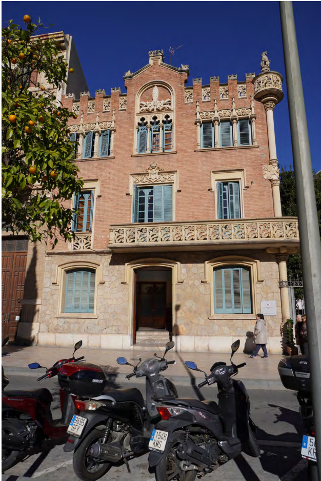
Imatge 1. Façana sud (carrer Sant Joan)
