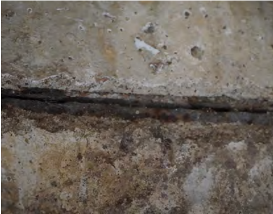
Imatge: F1. Oxidació perfil laminar.
