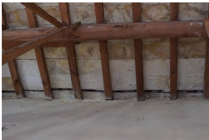
Imatge 023 - Obertura entre rajols de la solera per lliscament del tauler ceràmic
