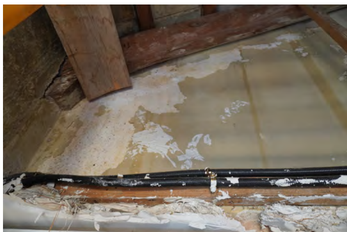
Imatge 024 - Deteriorament de la part superior dels paraments interiors dels murs
