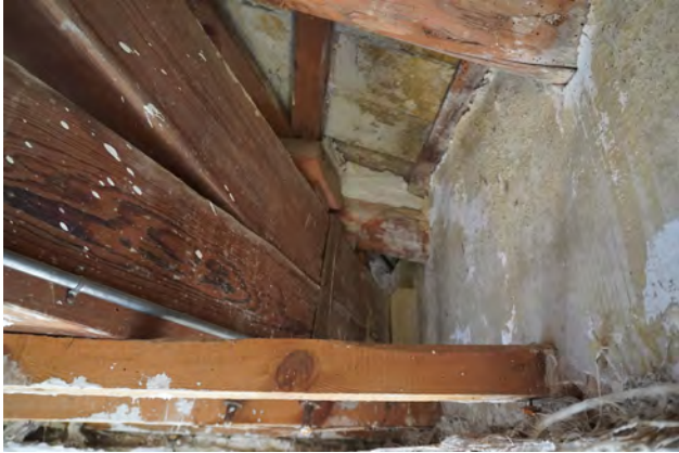
Imatge 5. Extrem encavallada l
