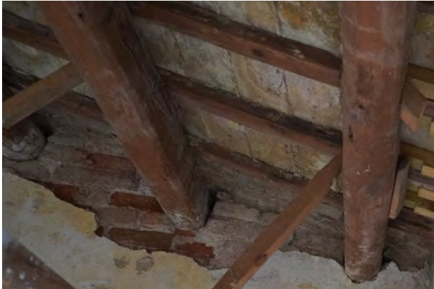
Imatge 1. Revisar caps bigues D-01 a D-09. Reforç estructural si s'escau.
