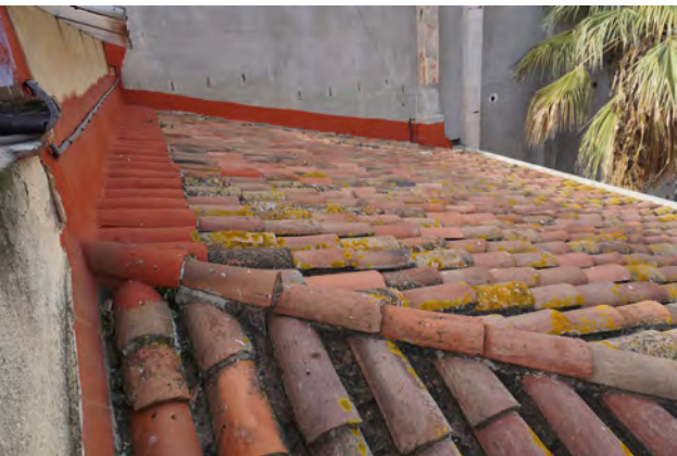
Imatge 3. Impermeabilització amb pintura bituminosa
