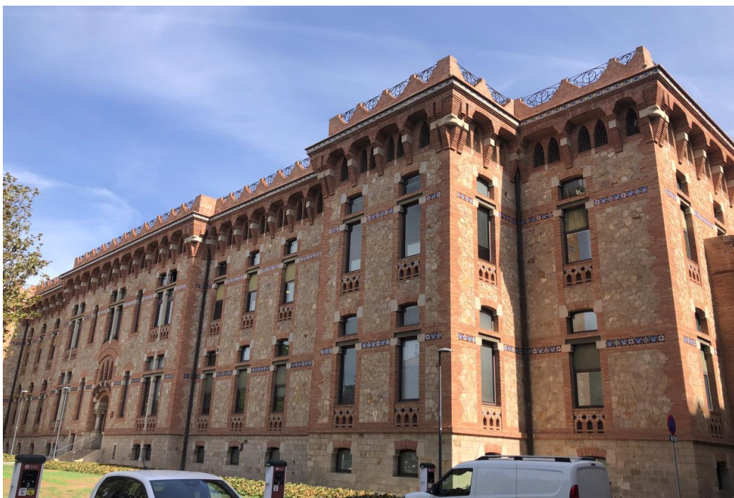
Figura 3: Façana principal edifici Mestral.
