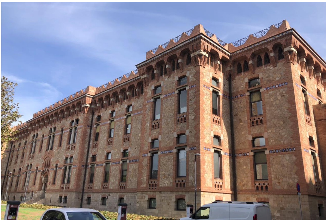
Figura 4: Façana principal edifici Mestral.
