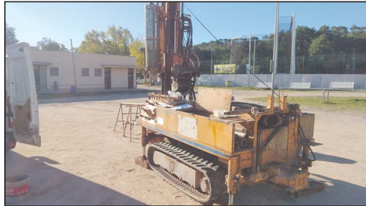
Fotografia 1. Vista de l'emplaçament de la màquina per a la realització del sondeig a rotació amb bateria continua S-1.
