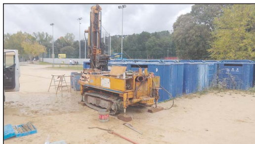
Fotografia 1. Vista de l'emplaçament de la màquina per a la realització del sondeig a rotació amb bateria continua S-3.
