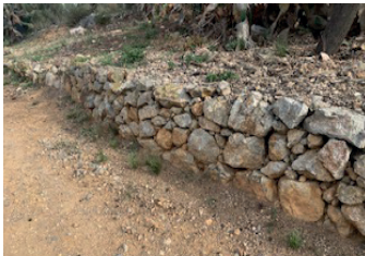
Mur pedra seca existent. h 40 -cm.
