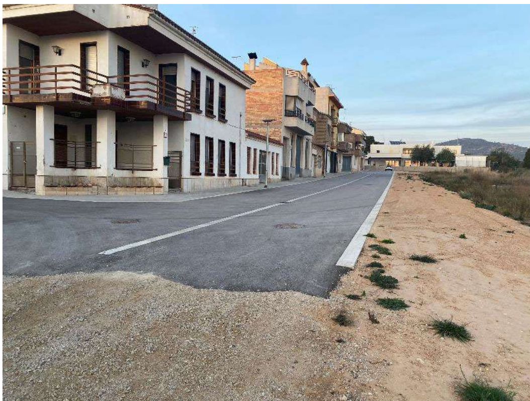
Carrer Solicru (vista de sud a nord), vorera a executar en fase 2
