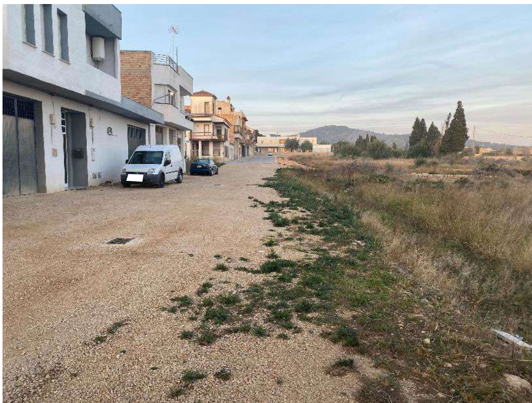
Vista tram pendent executar carrer Solicru (Fase 2) i vorera est (a executar en la seva totalitat en fase 2)
