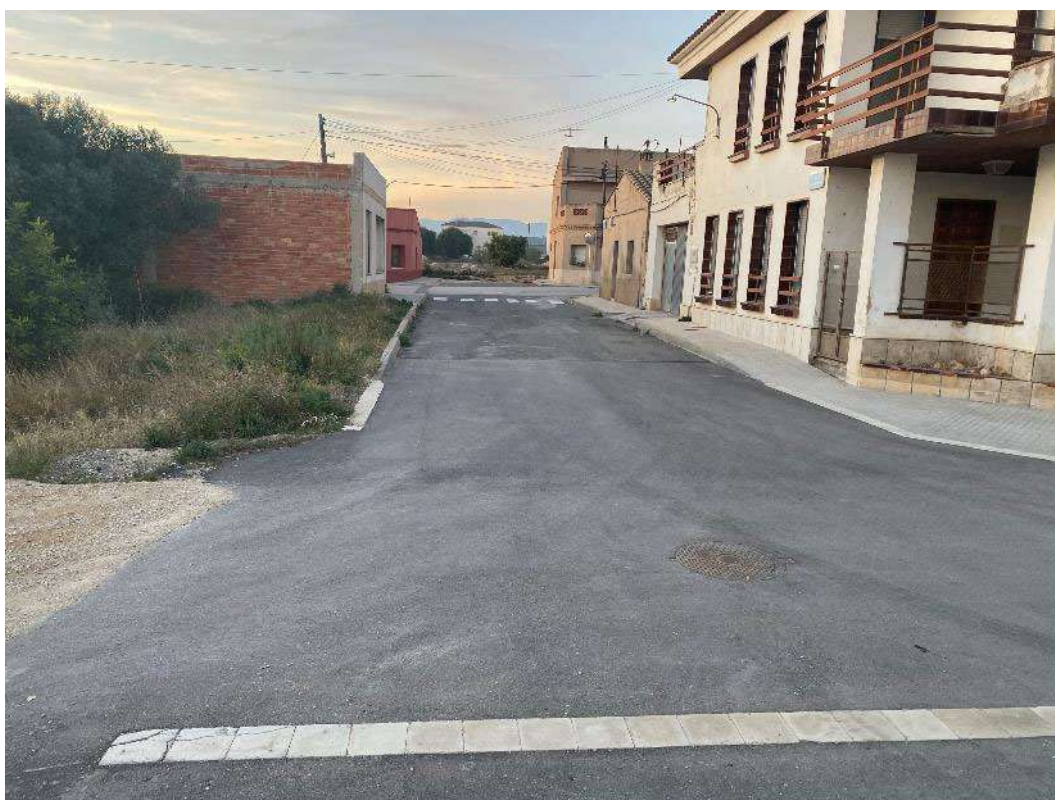
Vista carrer Sant Joan (executat en fase 1)
