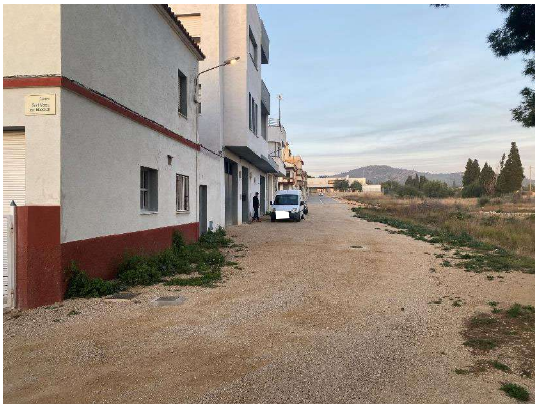
Carrer Solicru (vista de sud a nord)
