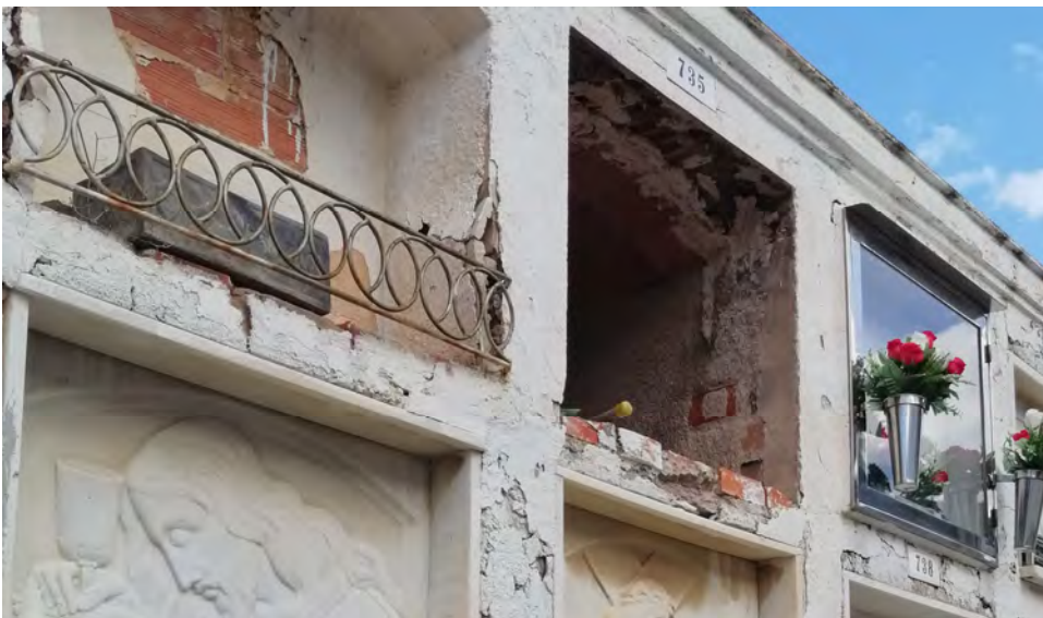
IMATGES DE LES PATOLOGIES GREUS EN ELS REVESTIMENTS AMB RISC DE DESPRENIMENT
