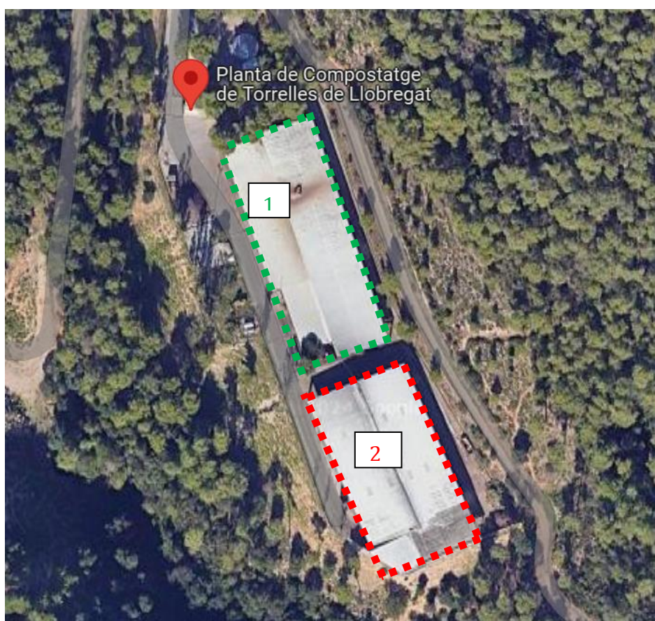
Fig. 1. Fotografia aèria de les naus 1 i 2 de la planta de compostatge de Torrelles
