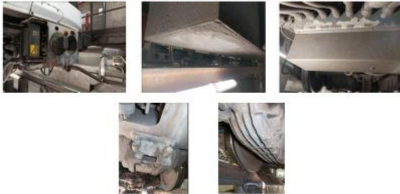
UT13:- Enganche, cofre ATP, caja CC16, motor de tracción, reductora
