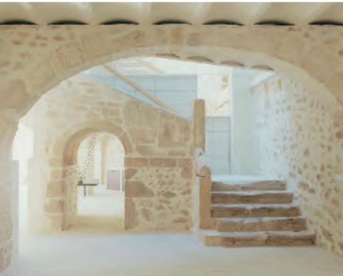
Imatge de referència rejuntat amb morter de calç
