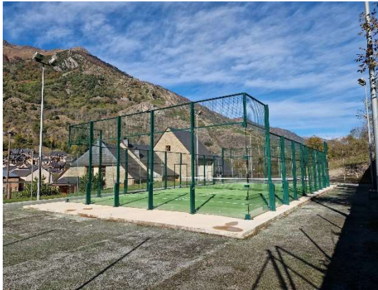
Imatge 10. Vista sud-oest de la pista de pàdel.
