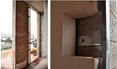
Ref. 01. Ejemplo anclaje pre-marco de las carpinterías Example pre-frame anchoring of the carpentry
