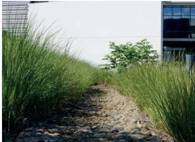
Exemple de cunetes d'infiltració d'aigües d'escorrentia vegetades
