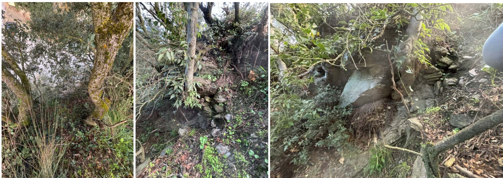
Vista de coronació de tram 1b lateral Oest, vegetació existents i petites falques intercalades.
