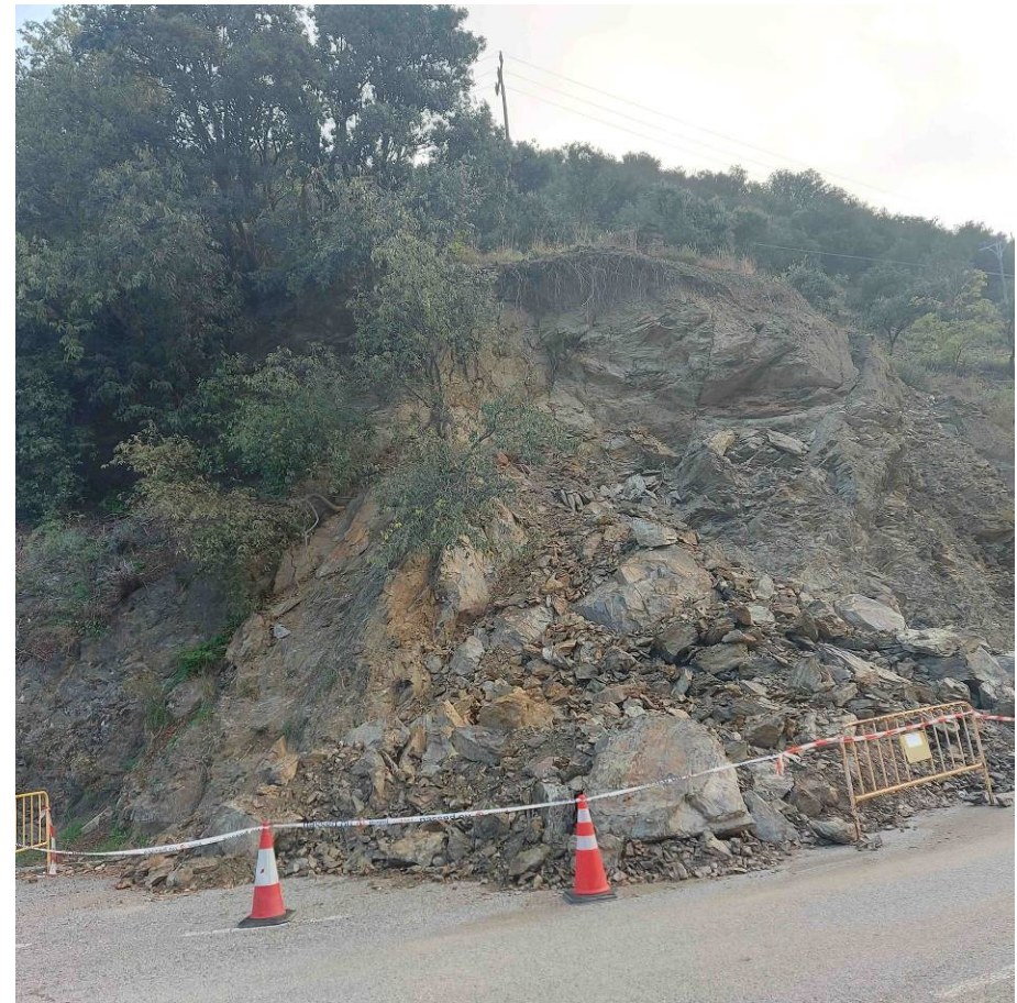
Vista general frontal de tram 1b a estabilitzar, en tram central de 18 m de longitud. A l'esquerra l'estat del talús abans de l'esllavissada (Google Maps), a la dreta l'estat final després de l'esllavissada.
