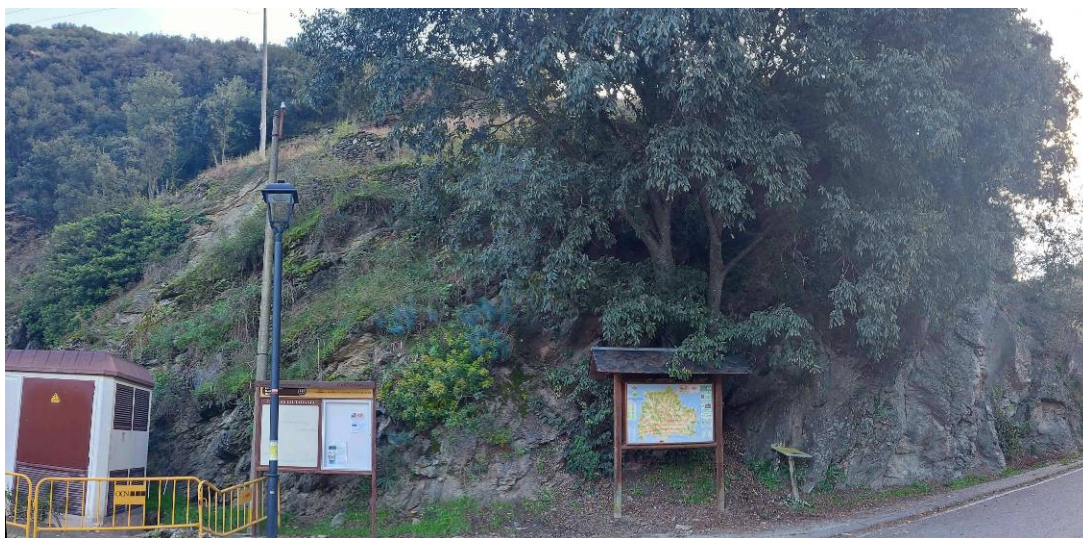
Vista de tram 1a a estabilitzar.
