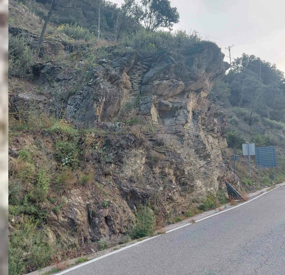
ESTABILITZACIÓ DE TALÚS núm. 2
