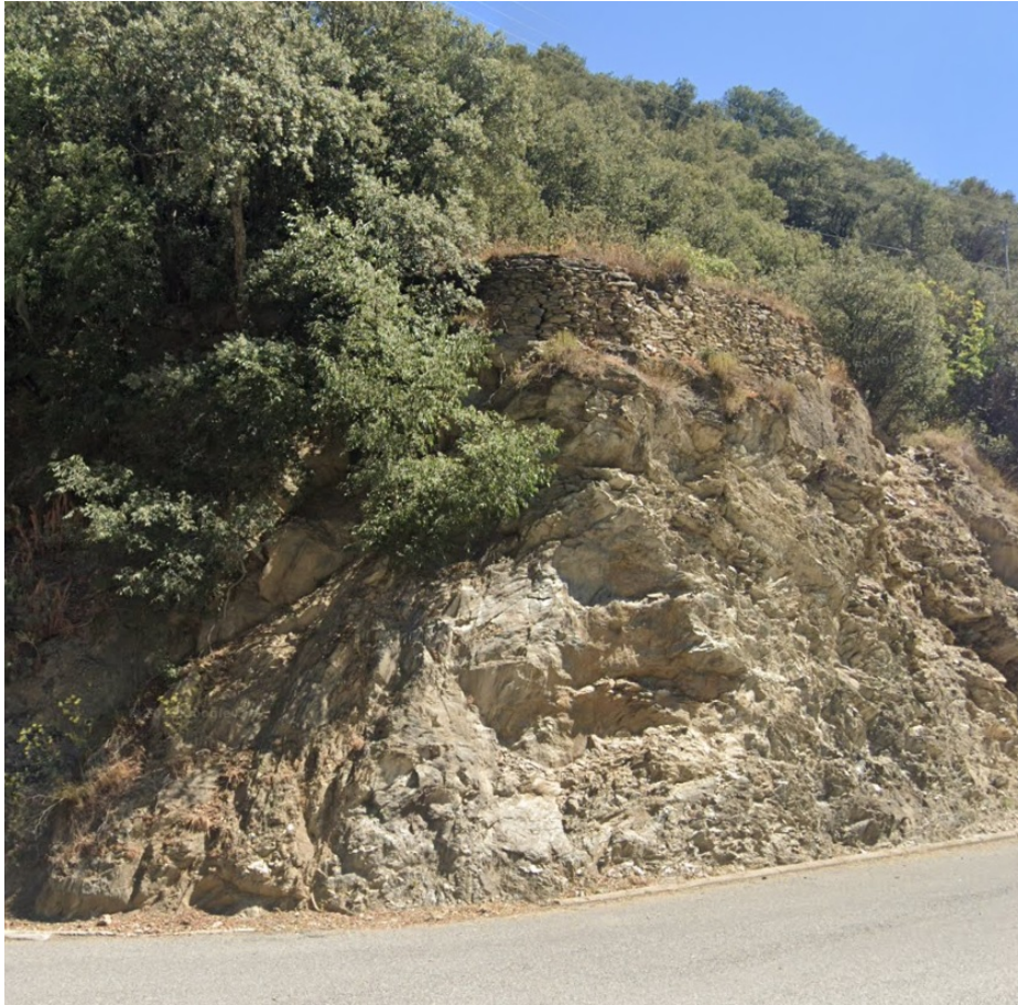
Vista general frontal de tram 1b a estabilitzar, en tram central de 18 m de longitud. A l'esquerra l'estat del talús abans de l'esllavissada (Google Maps), a la dreta l'estat final després de l'esllavissada.
