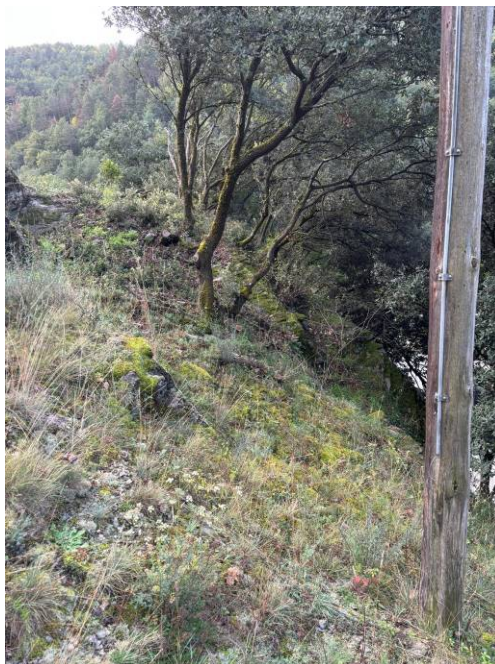
Vista de cap de talús de tram 1a, sense esquerdes de tracció apreciables.
