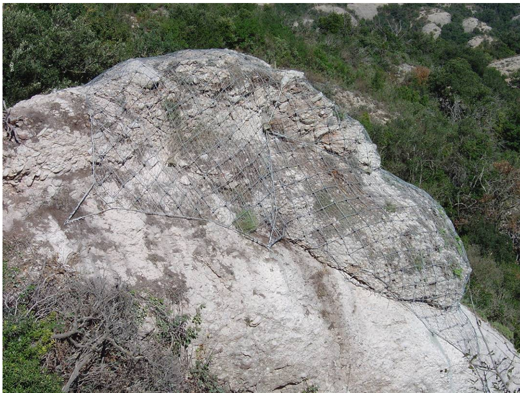
Exemple de malla d'estabilització amb panells de xarxa de cable d'acer i malla de doble trenat.
