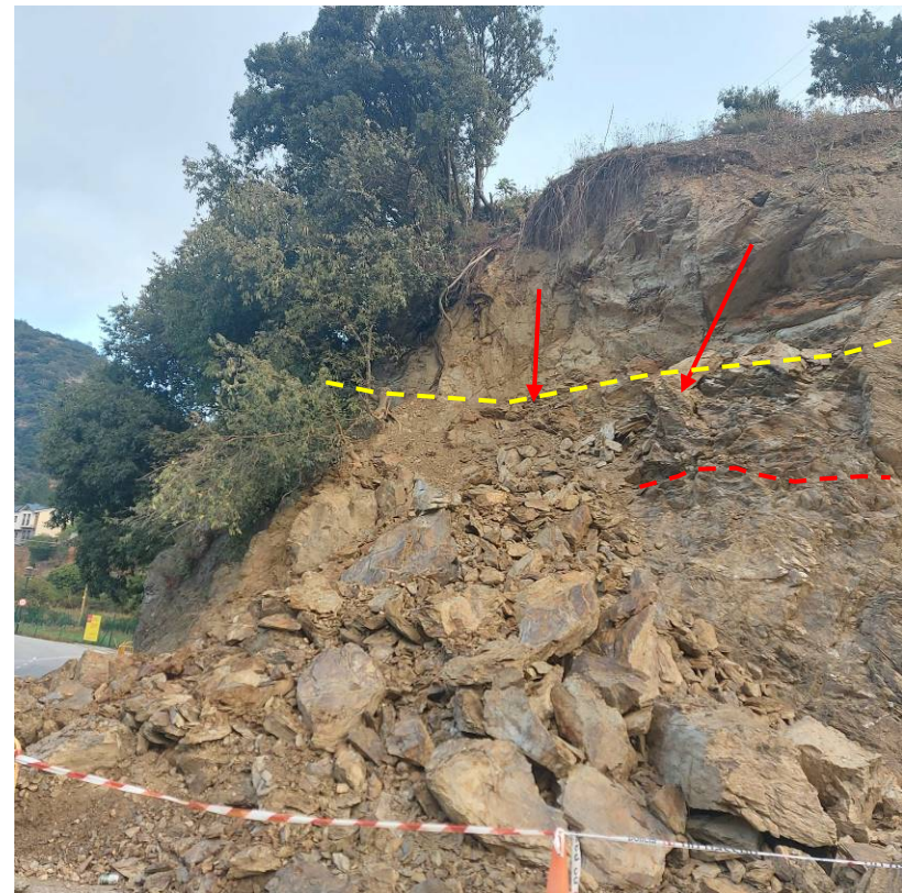
Vista de detall lateral de tram 1b central a estabilitzar esllavissat de 18 m de longitud. A l'esquerra l'estat del talús abans de l'esllavissada (Google Maps), a la dreta l'estat final després de l'esllavissada. S'indica a l'esquerra l'estratificació fina de les lutites en posició semihoritzontal, formant voladís. S'indica a la dreta les falques romanents després de l'esllavissada i s'observa a la dreta com
