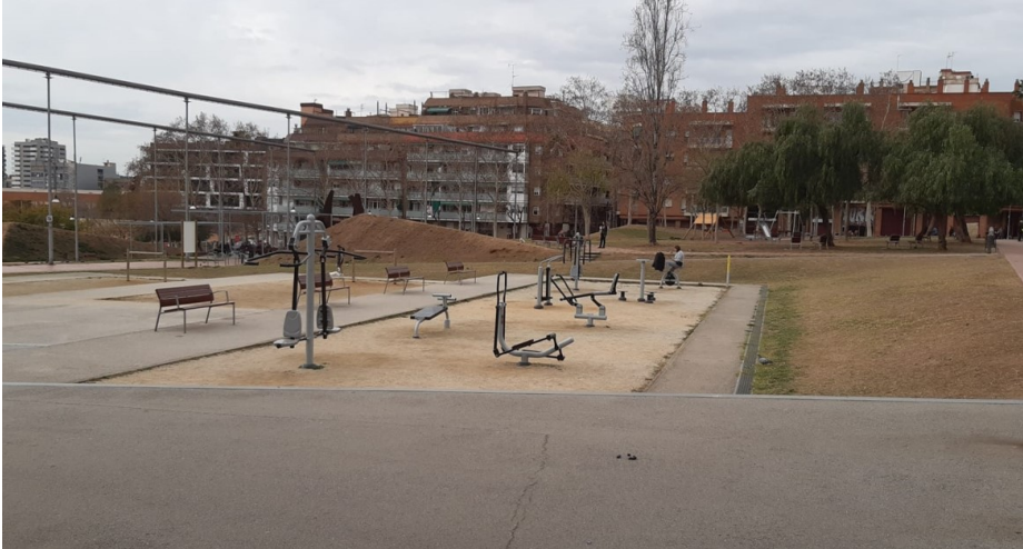
Estat actual de la zona de Fitness del Parc de la Solidaritat.
