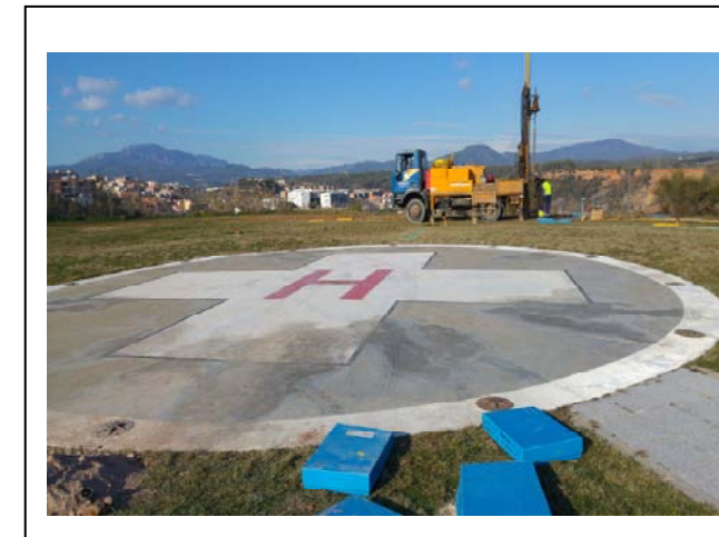
Foto 7: Sonda RL-400 al sondeig S-2. A l'heliport, Parc Taulí.
