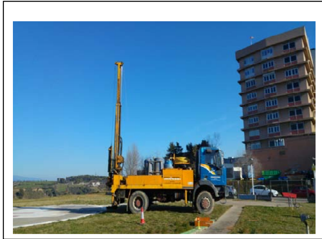
Foto 1: Sonda RL-400 al sondeig S-1. A l'heliport, Parc Taulí.
