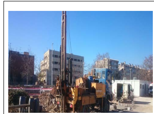
Foto 15: Sonda RL-400 al sondeig S-3. A l'heliport, Parc Taulí.
