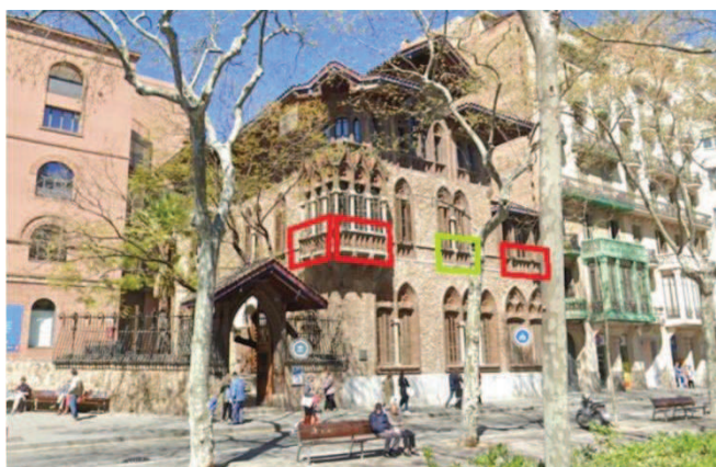
Façana Gran Via de les Corts Catalanes, 491
